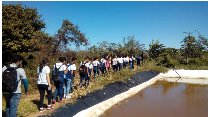
Figura 25 - Tanque de armazenamento de água salina.
