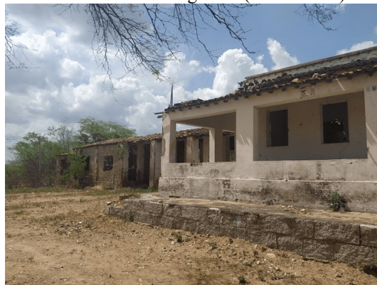
Figura 22- Ruínas da edificação chamada de Casa-grande (Vila Centro)
