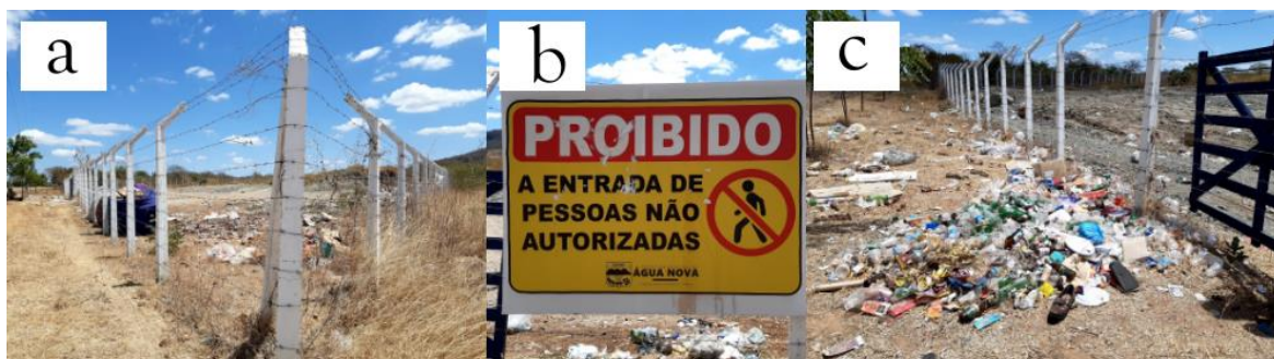
Figura 7 - Características locais, estruturais e operacionais do aterro: a) Estrutura de isolamento. b) Placa de acesso. c) Resíduos expostos em frente (área externa) ao aterro.
