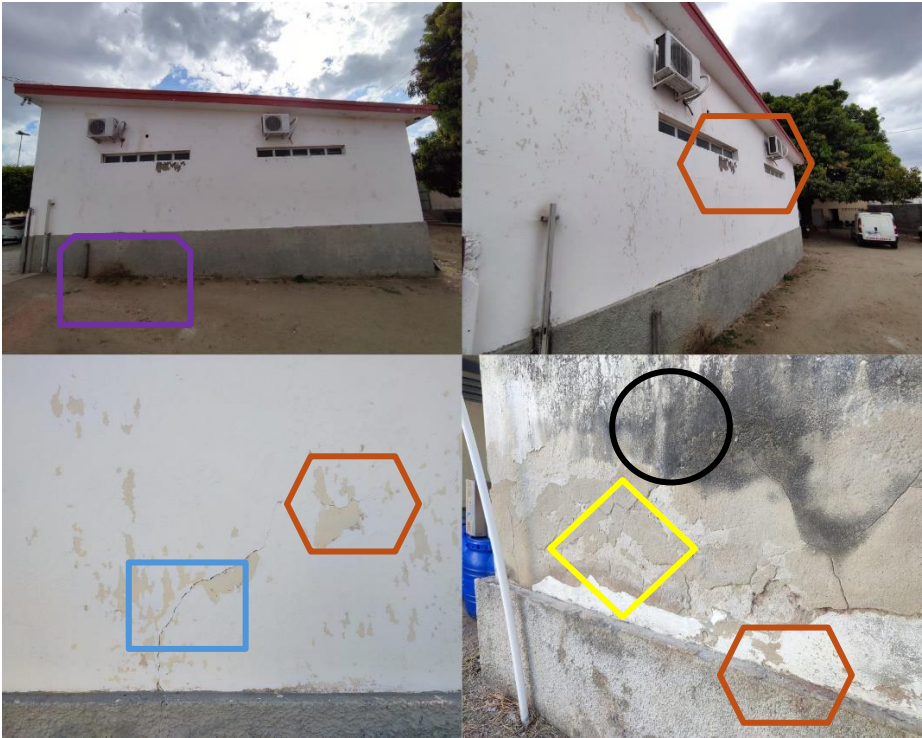
Figura 6: Mapeamento de manifestações nas fachadas.
