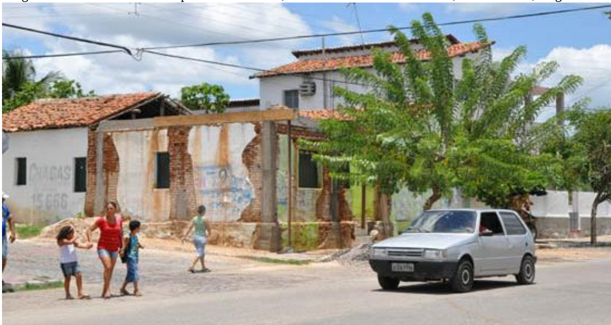
Figura 92. Vista externa de um prédio em reforma, localizado na Rua José Rufino, bairro Centro, Angicos/RN
