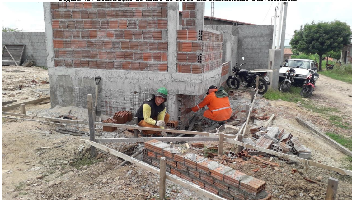
Figura 43. Construção do muro do bloco das Residências Universitárias
