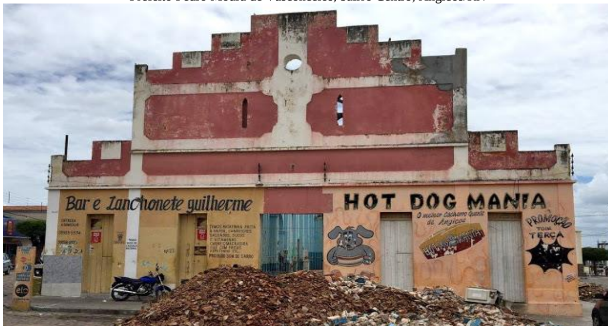
Figura 98. Vista externa da reforma do Mercado Público Municipal, localizado entre as ruas Expedito Alves e Prefeito Pedro Moura de Vasconcelos, bairro Centro, Angicos/RN
