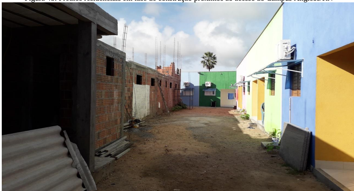
Figura 45. Prédios residenciais em fase de construção próximos ao acesso ao Campus Angicos/RN
