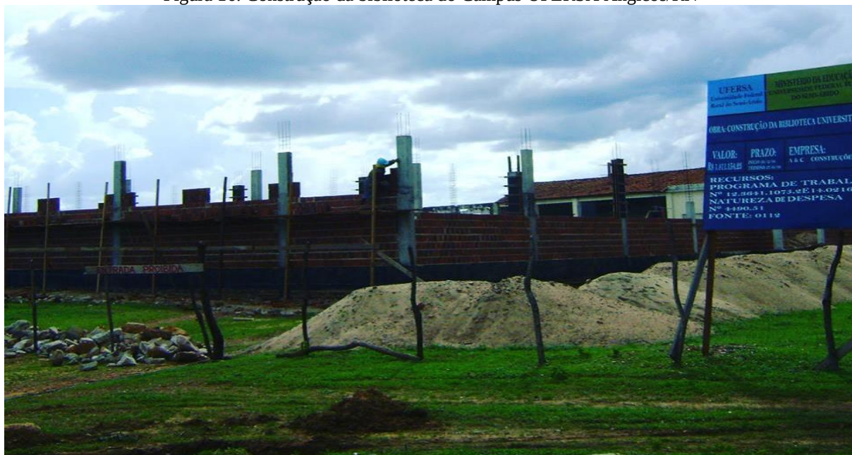
Figura 16. Construção da biblioteca do Campus UFERSA Angicos/RN
