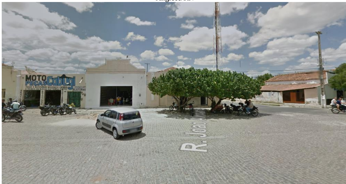
Figura 90. Vista de um depósito de material de construção, localizado na Rua João Alexandre, bairro Centro, Angicos/RN
