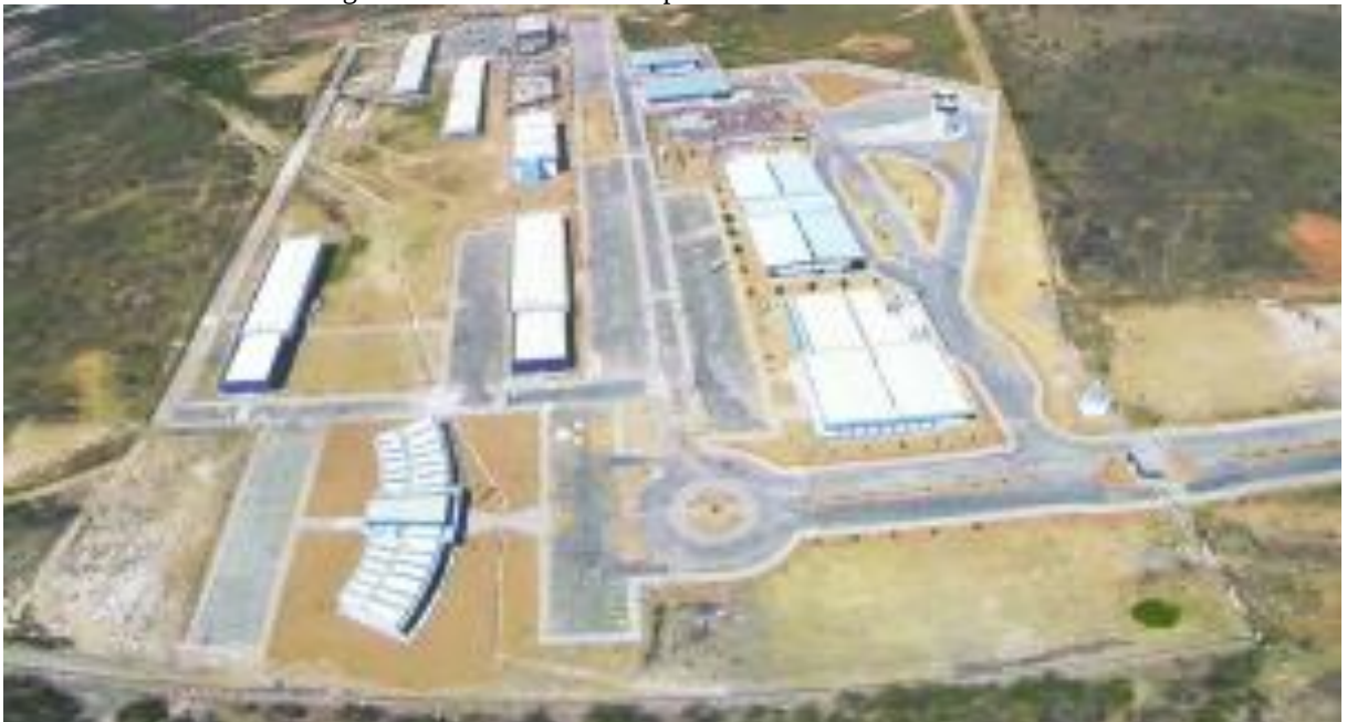
Figura 7. Vista aérea do Campus Caraúbas/RN da UFERSA
