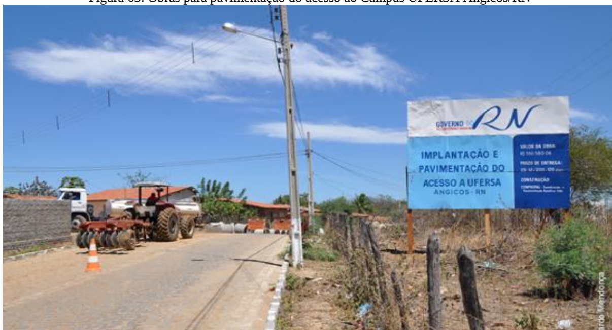
Figura 63. Obras para pavimentação do acesso ao Campus UFERSA Angicos/RN
