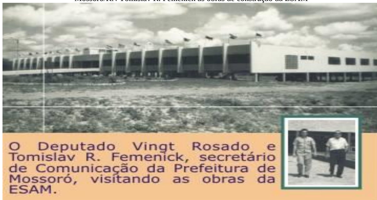
Figura 13. Visita do deputado federal Vingt Rosado e do secretário de comunicação da prefeitura de Mossoró/RN Tomislav R. Femenick as obras de construção da ESAM
