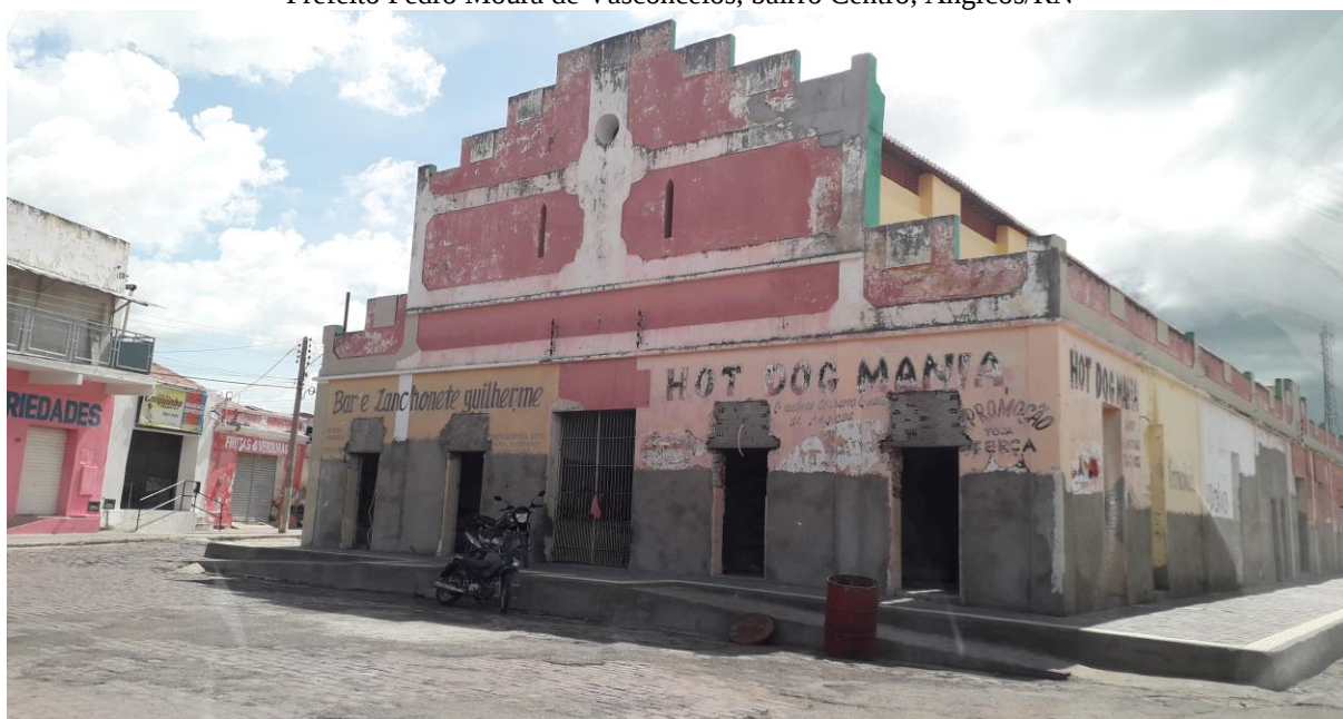
Figura 99. Vista externa do Mercado Público Central Municipal, localizado entre as ruas Expedito Alves e Prefeito Pedro Moura de Vasconcelos, bairro Centro, Angicos/RN
