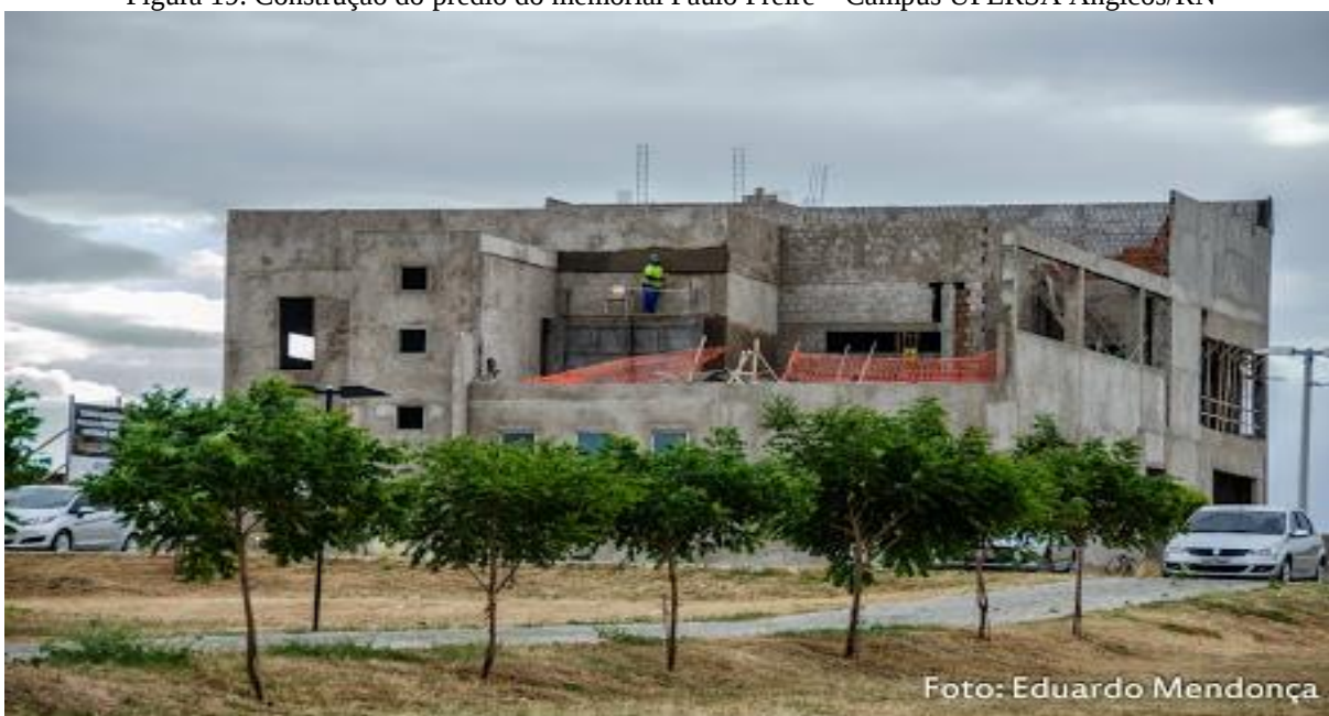
Figura 19. Construção do prédio do memorial Paulo Freire – Campus UFRSA Angicos/RN
