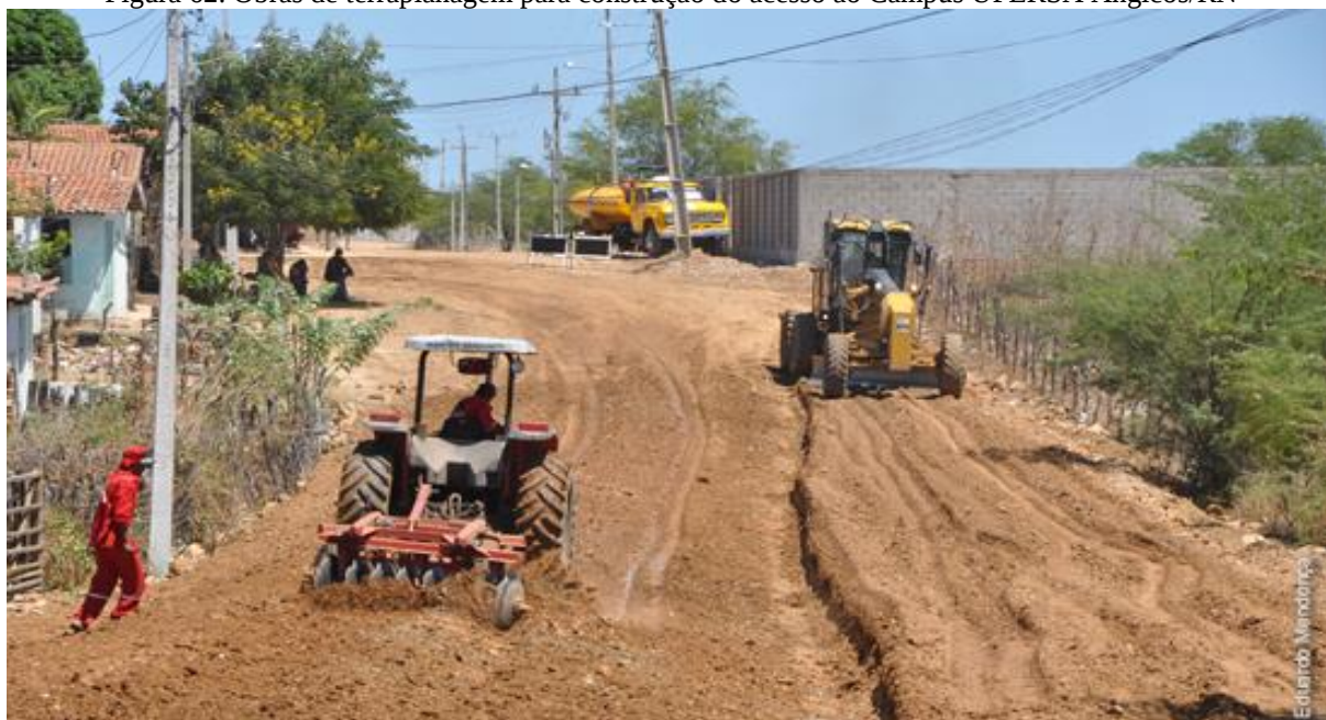
Figura 62. Obras de terraplanagem para construção do acesso ao Campus UFERSA Angicos/RN
