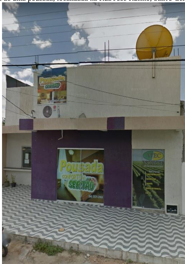
Figura 94. Vista de uma pousada, localizada na Rua José Rufino, bairro Centro, Angicos/RN
