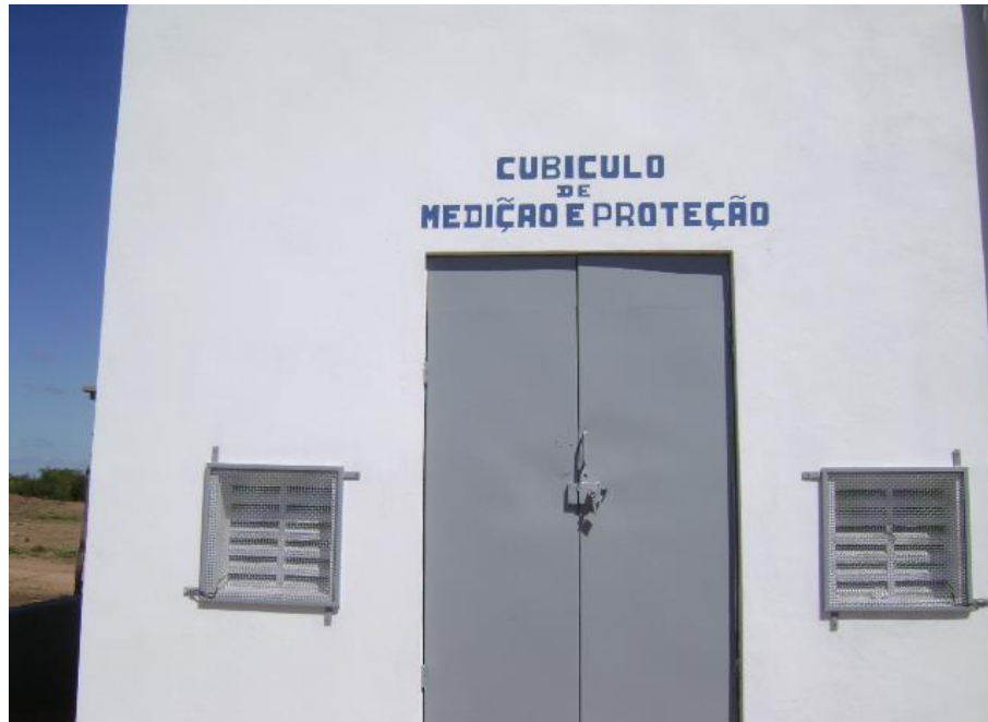
Figura 25 – Cubículo de medição e proteção
