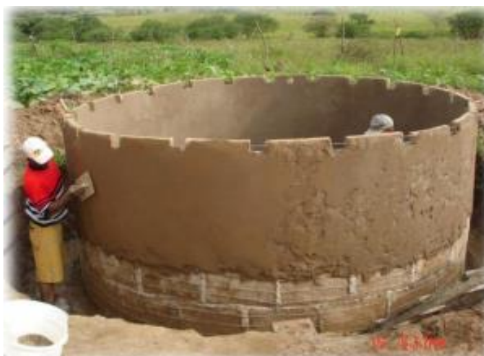
Figura 17: Aspecto do reboco externo da cisterna
