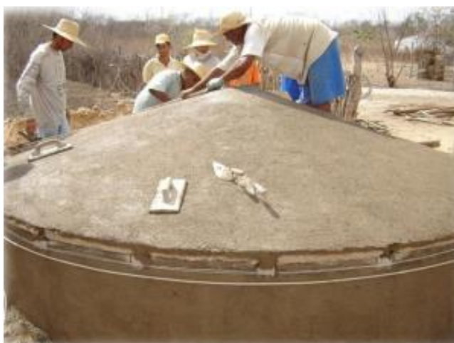
Figura 16: Reboco do teto
