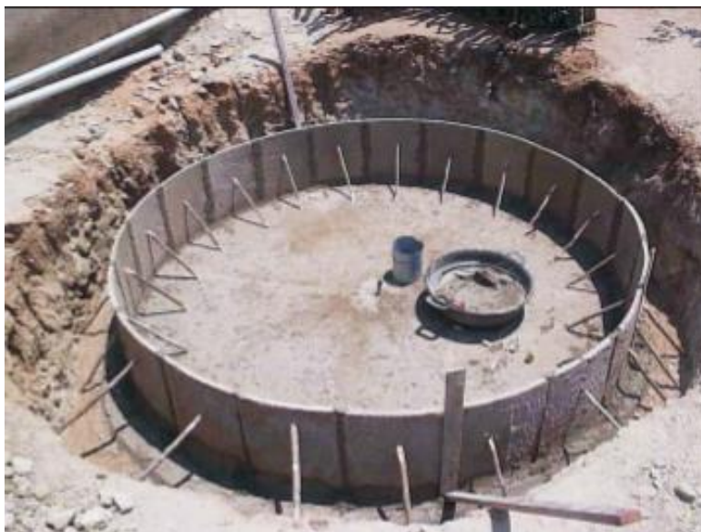
Figura 13: Detalhes da montagem da primeira fileira
