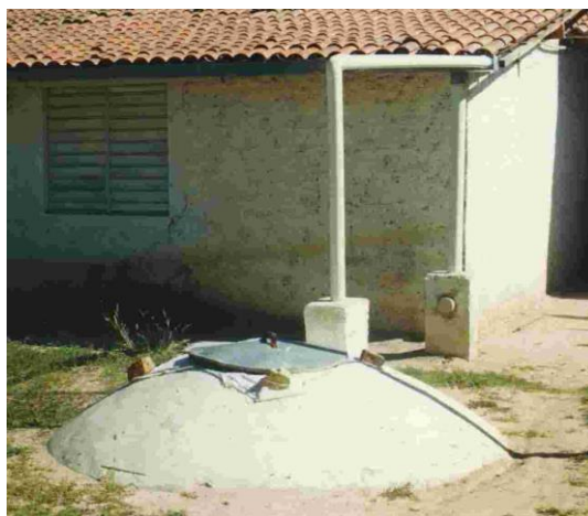
Figura 4: Cisternas de Tijolos e Argamassa
