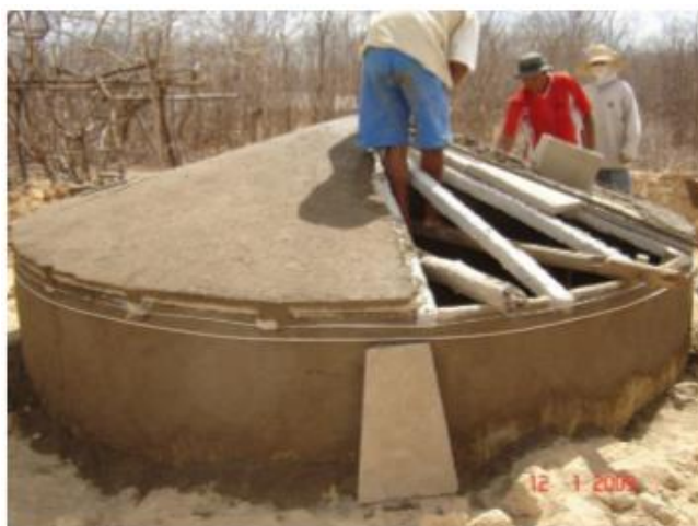
Figura 15: Colocação das placas do teto
