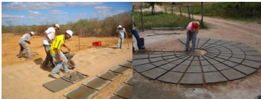
Figura 9: Fabricação das placas
