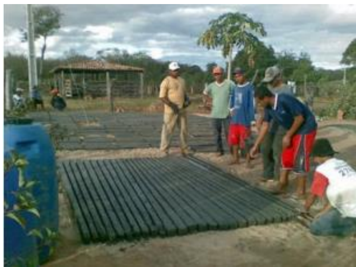
Figura 10: Confeção dos caibros da cisterna de placas
