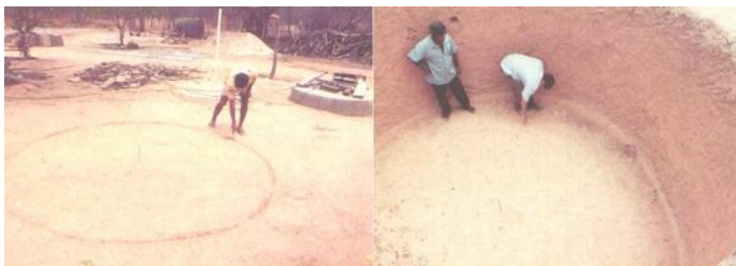
Figura 6: Marcação do local da cisterna/escavação do alicerce
