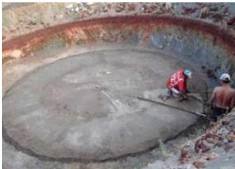
Figura 12: Aspecto do piso do fundo da cisterna
