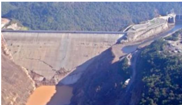
Figura 25 - Barragem UHE Campos Novos. Fonte: (WILLINGHOEFER, 2015)
