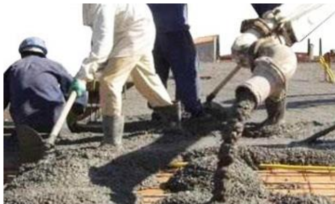
Figura 23 - Concretagem por meio de bombeamento. Fonte: https://www.eduric.com.br/produtos.html
