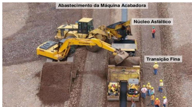
Figura 22 - Transporte e lançamento de concreto asfáltico. Fonte: https://pt.slideshare.net/rcdesenhos/barragem-de-enrocamento-com-nucleo-asfaltico-5651360
