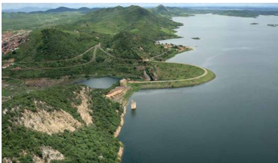
Figura 24 - Barragem de Orós. Fonte: (MELLO, 2011).
