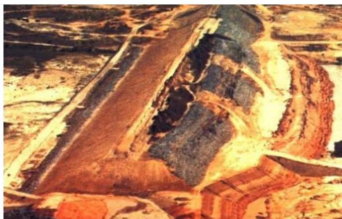
Figura 26 - Ruptura na barragem Eng. Armando Ribeiro Gonçalves. Fonte: https://docplayer.com.br/64756007-Acidentes-barragens-no-brasil.html
