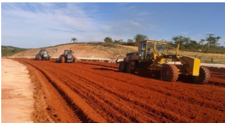
Figura 17 - Homogeneização do solo. Fonte: https://www.satel.com.br/tudo-que-voce-precisa-saber-sobre-terraplenagem/
