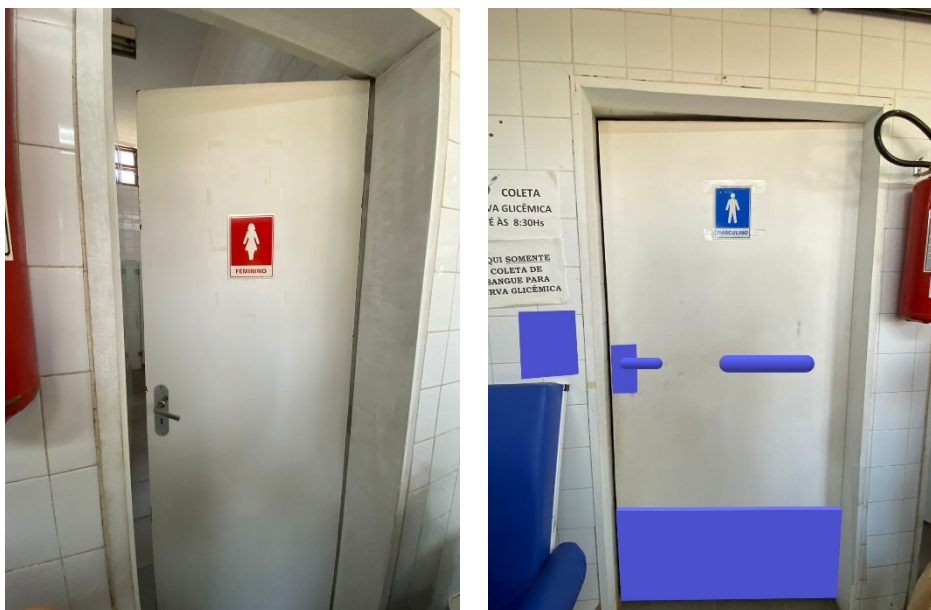
Figura 6 – Sinalização na porta de banheiros e croqui de adequação.
