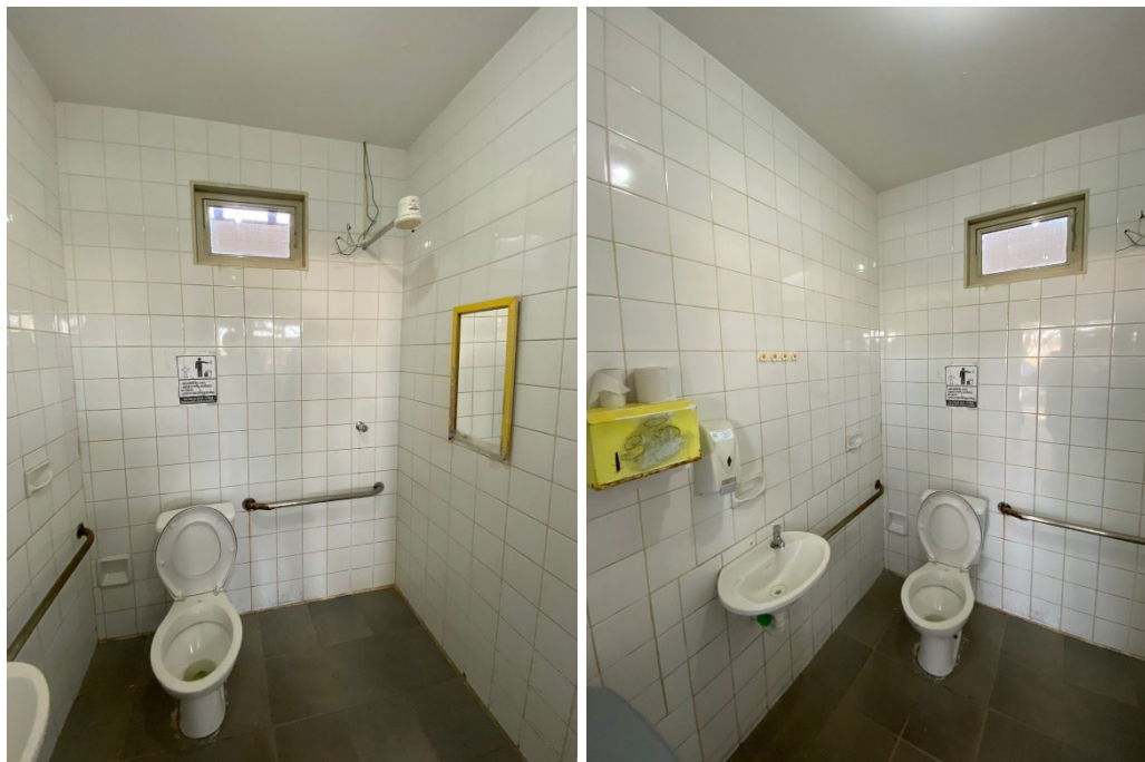
Figura 9 – Barras de apoio em banheiro acessível.
