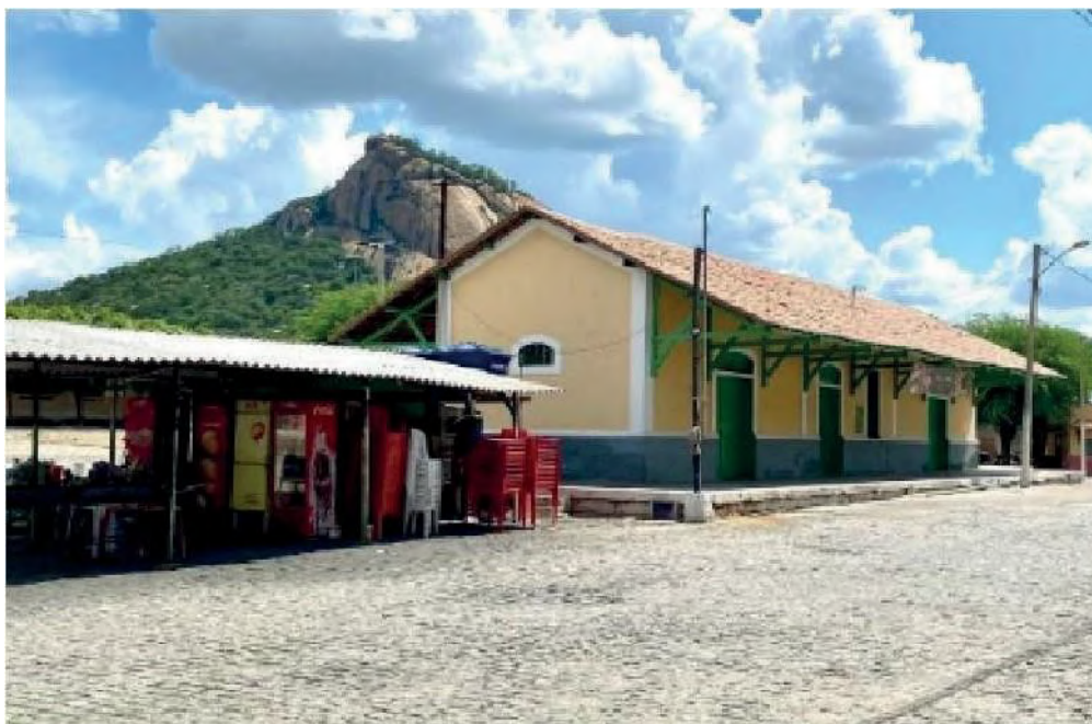
Figuras 36 – Fotografias do estado atual da Estação Ferroviária.
