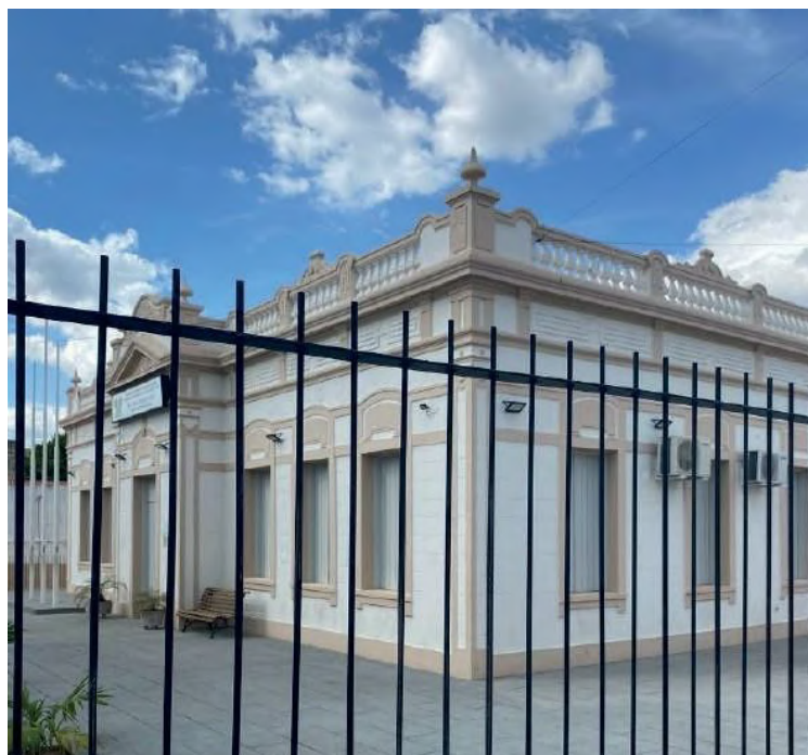
Figura 26 – Situação atual da Escola Waldemar de Sousa Veras
