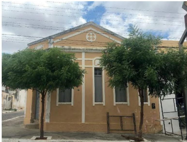
Figura 46 – Edificação residencial na Avenida Dr. Gregório de Paiva.
