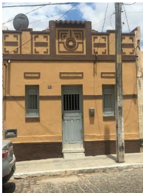
Figura 47 – Edificação residencial na Travessia Benício de Paiva.
