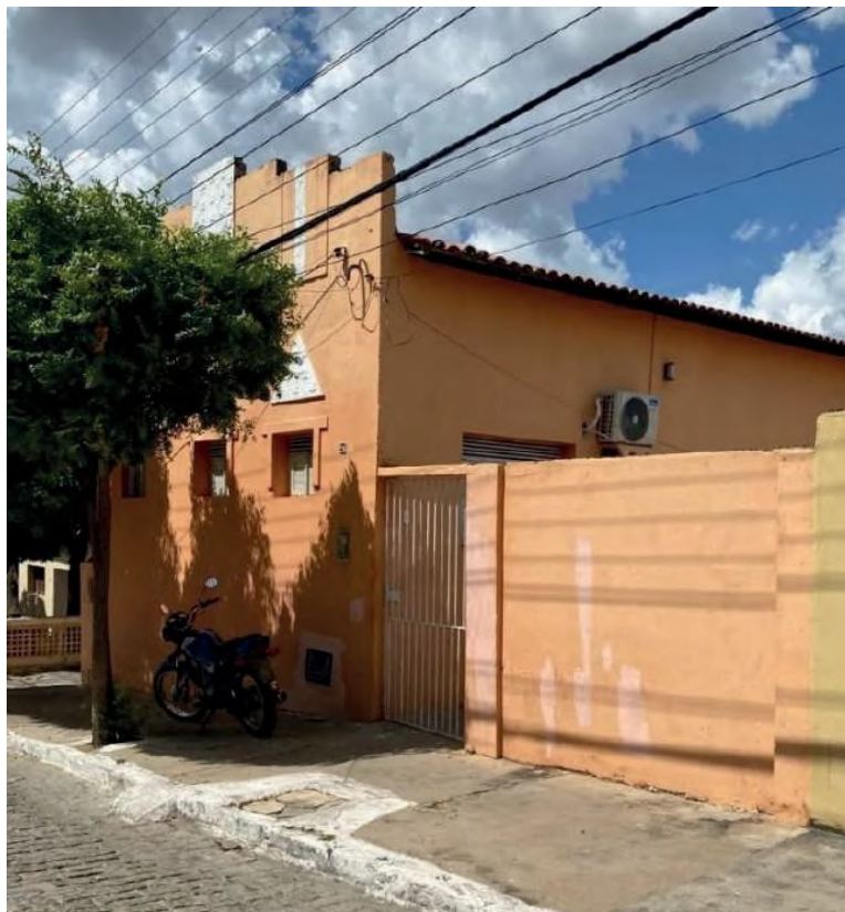
Figura 45 – Edificação residencial na Avenida Dr. Gregório de Paiva
