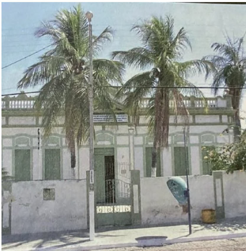
Figura 25 – Fotografia da fachada da escola no ano de 2007
