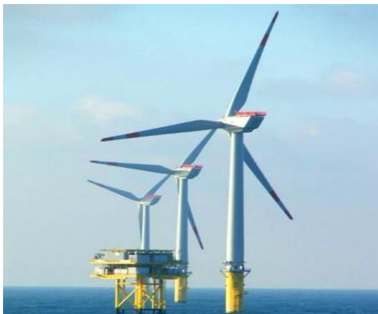
Figura 2: Turbinas do Parque Eólico Offshore Alpha Ventus, na Alemanha.
