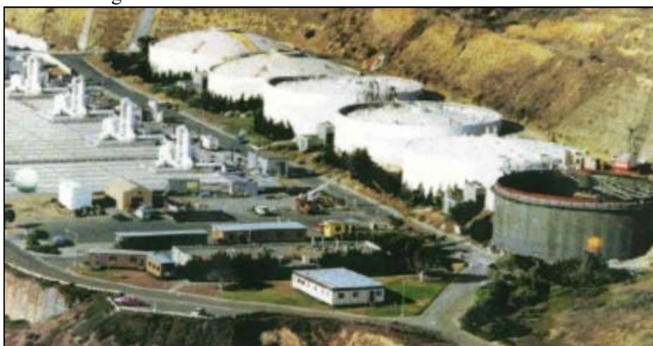
Figura 2.1: Reservatórios cilíndricos de concreto armado.
