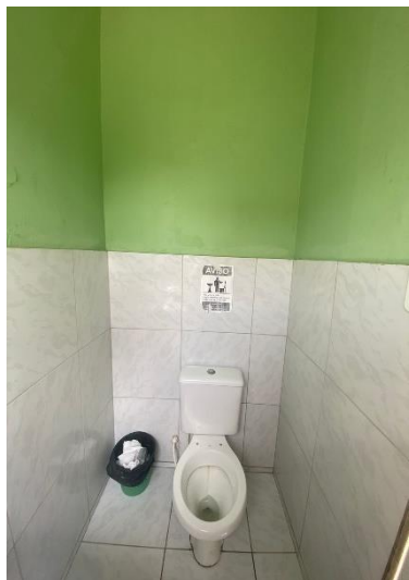
Figura 23- Banheiro UBS I
