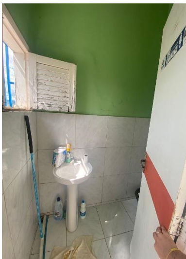
Figura 24- Banheiro UBS I.
