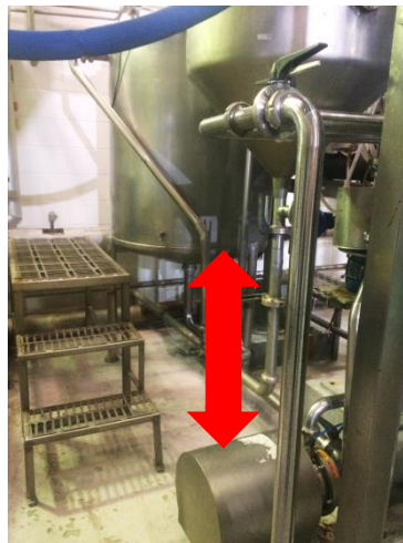
Figura 11 – Aproximação de bomba ao tanque de equilíbrio (Autoria própria, 2021).
