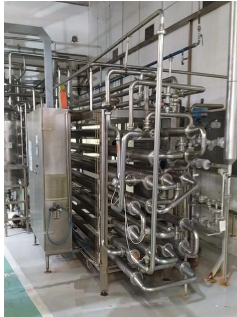
Figura 3 – Trocador de calor tubular para pasteurização de produtos (Autoria própria, 2021)
