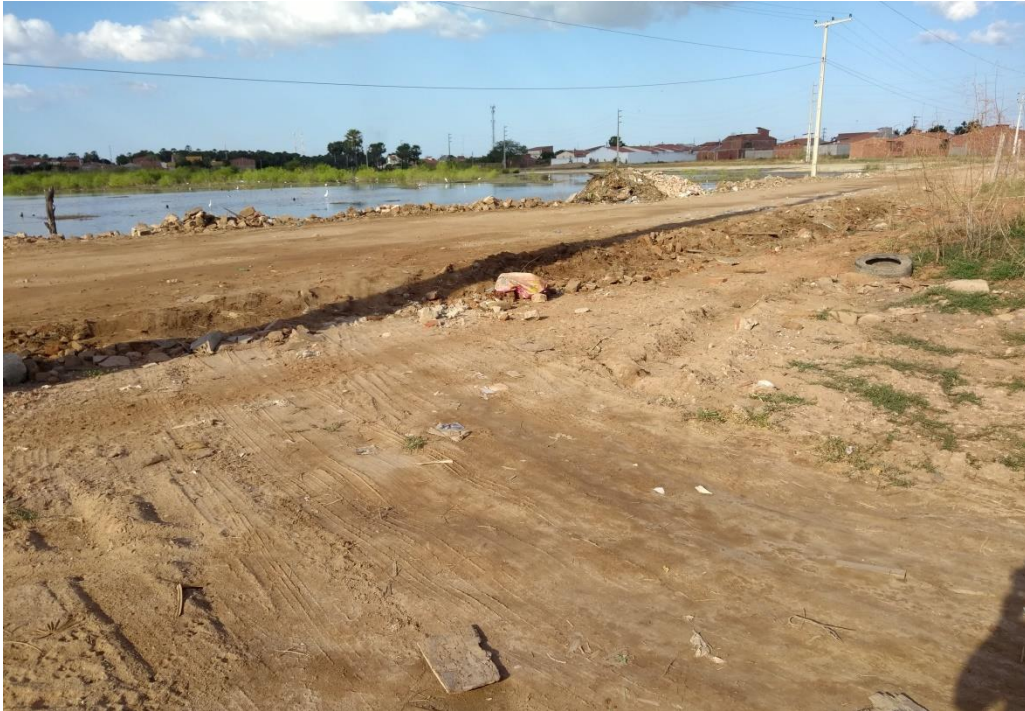
Figura 4 - Reaproveitamento de Resíduos da Classe A no aterro da Travessa Rio Valê, em Russas - CE
