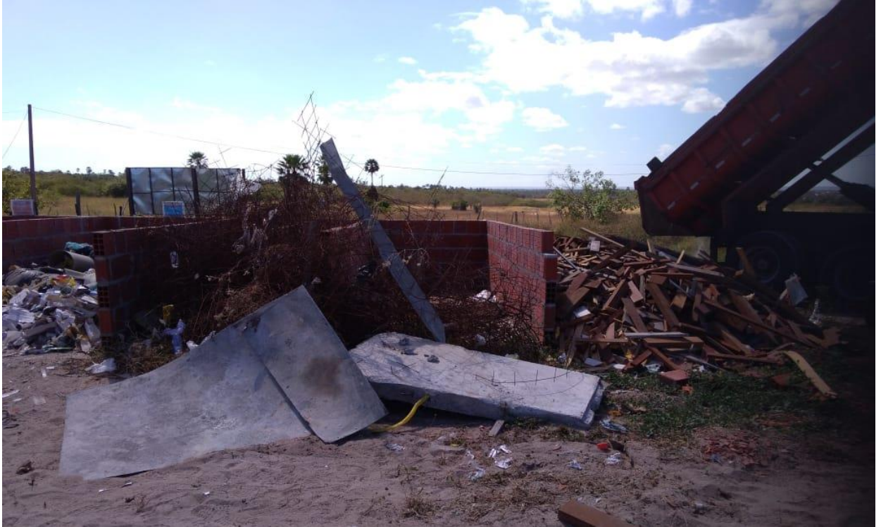
Figura 5 - Segregação dos RCD em empresa da cidade de Russas - CE
