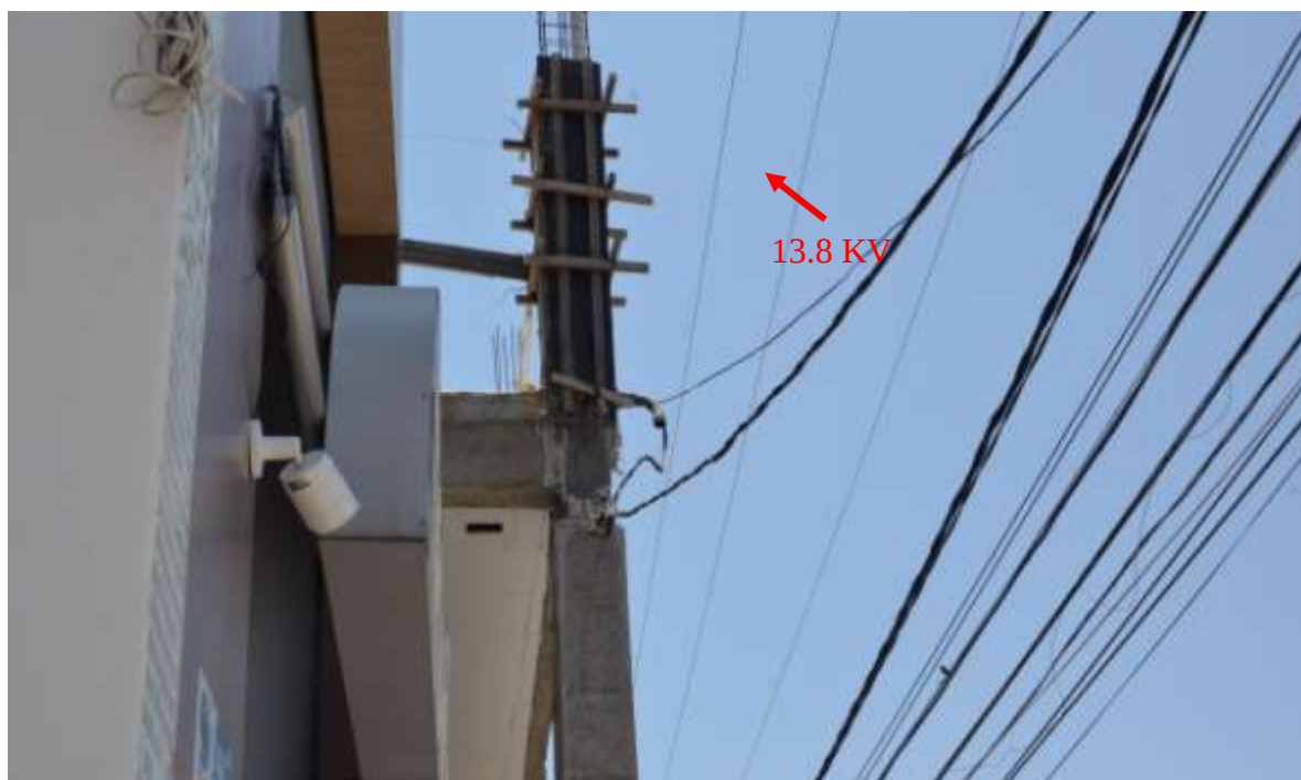
Figura 15- Local 5- Elemento estrutural
