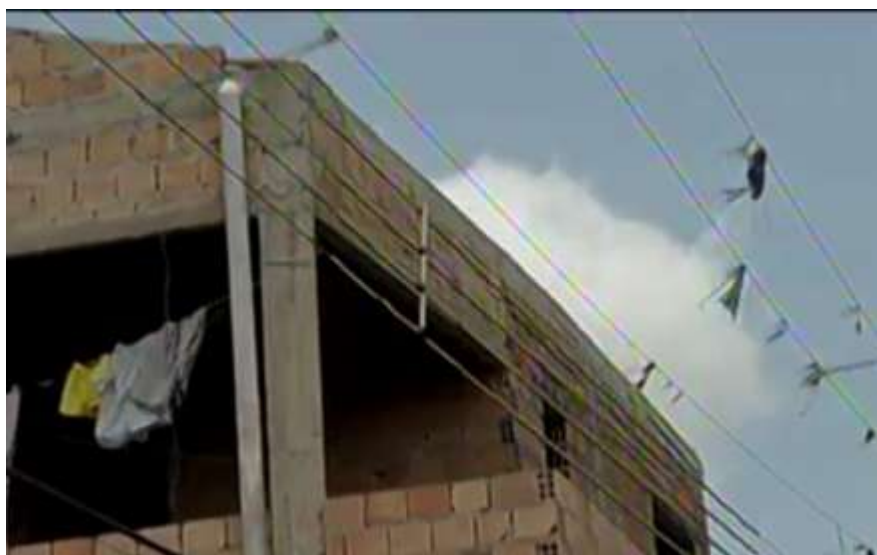
Figura 2- Rede elétrica próxima à residência no Pará.
