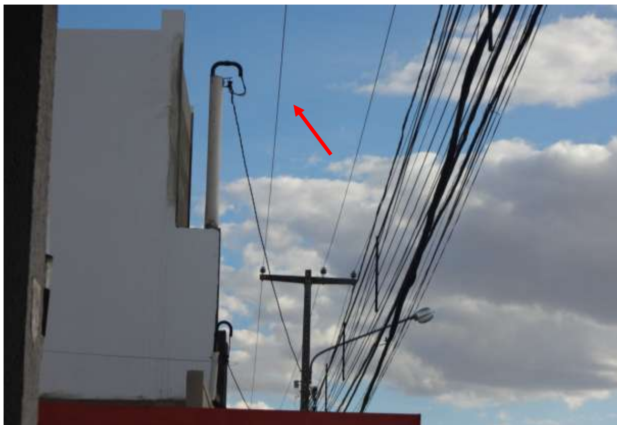
Figura 18- Local 7 – Vista lateral
