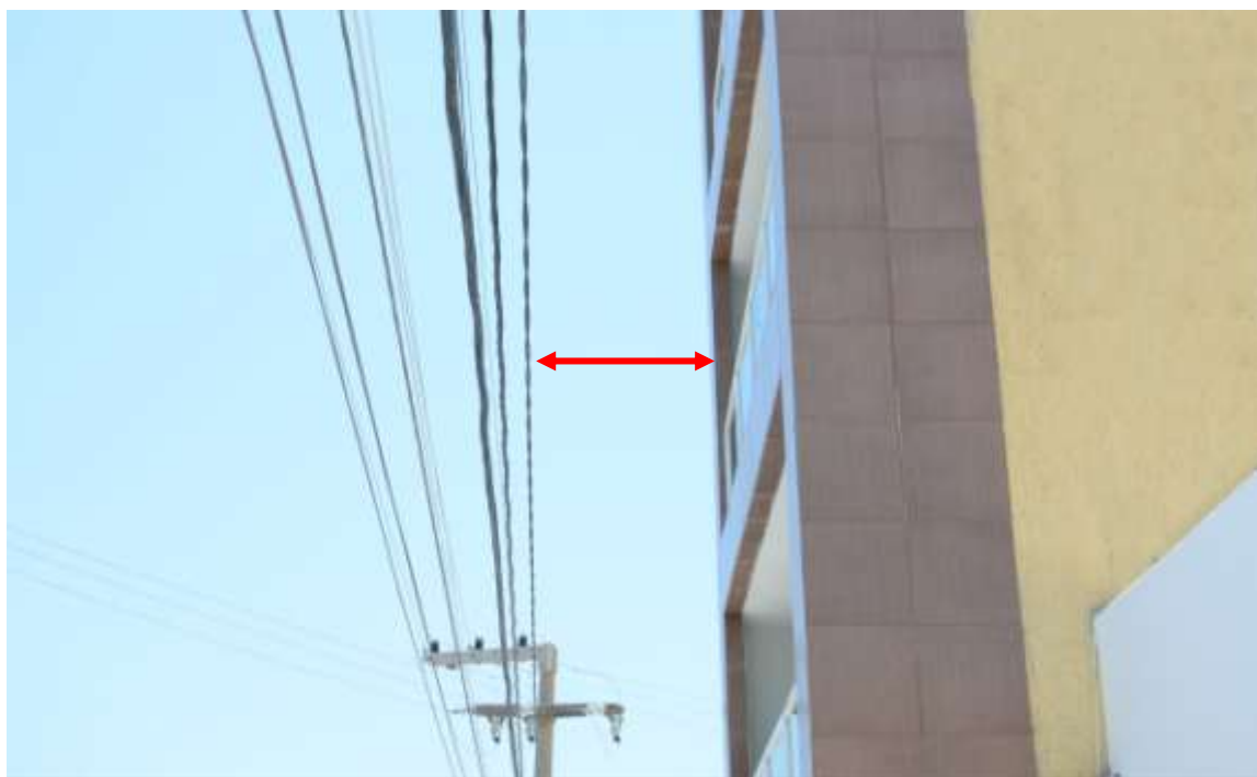
Figura 9- Local 1 – Vista lateral
