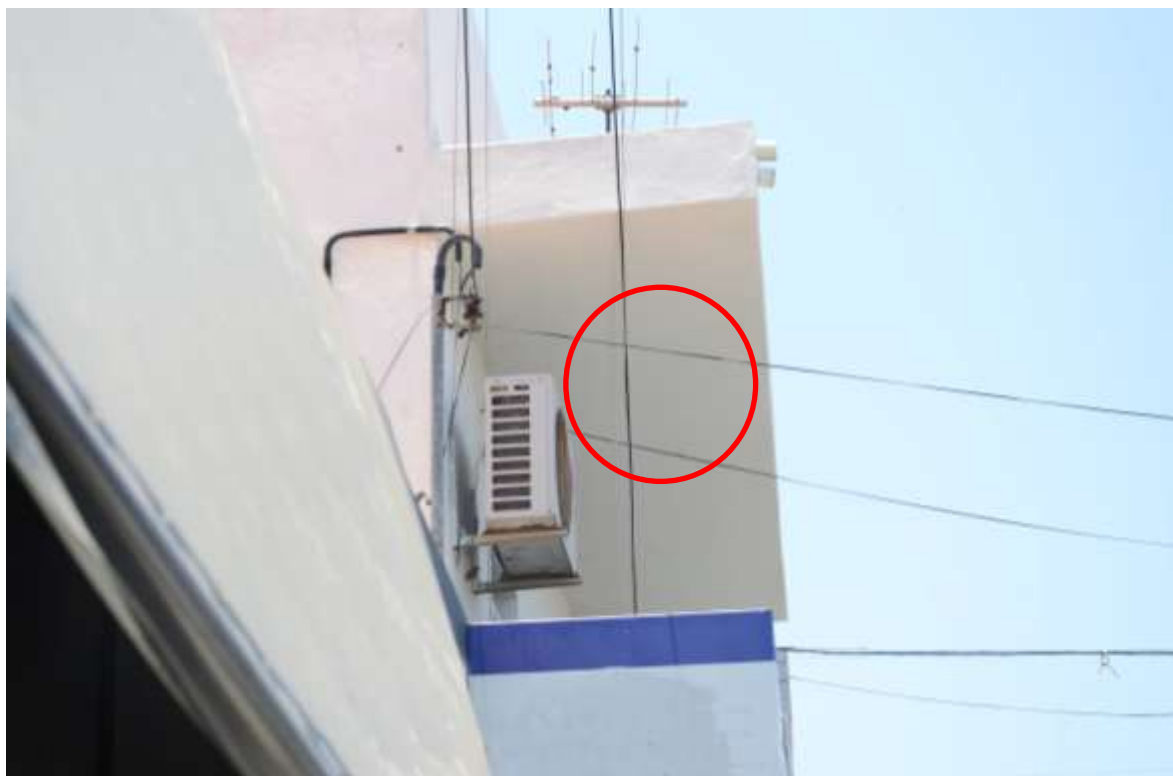
Figura 11- Local 2 – Vista lateral
