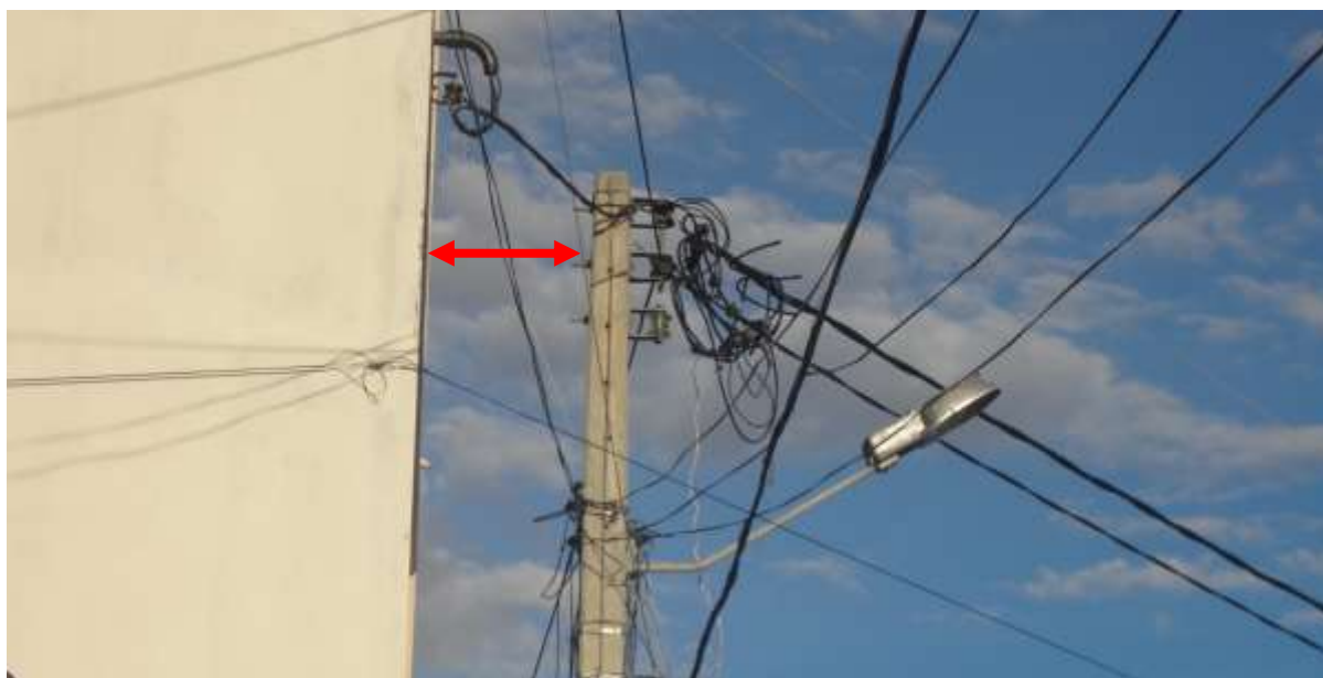
Figura 20- Local 8 – Vista lateral
