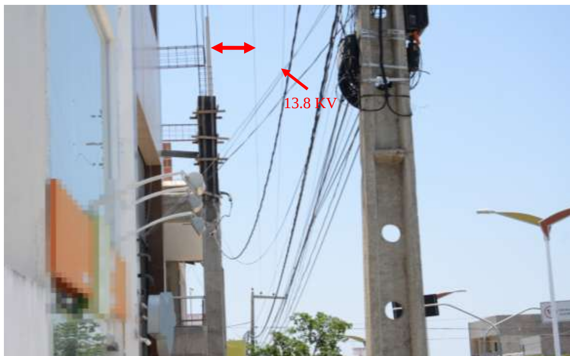
Figura 16- Local 5 – Vista lateral
