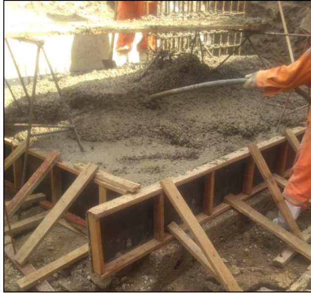
Figura 17: Adensamento executado com vibrador
