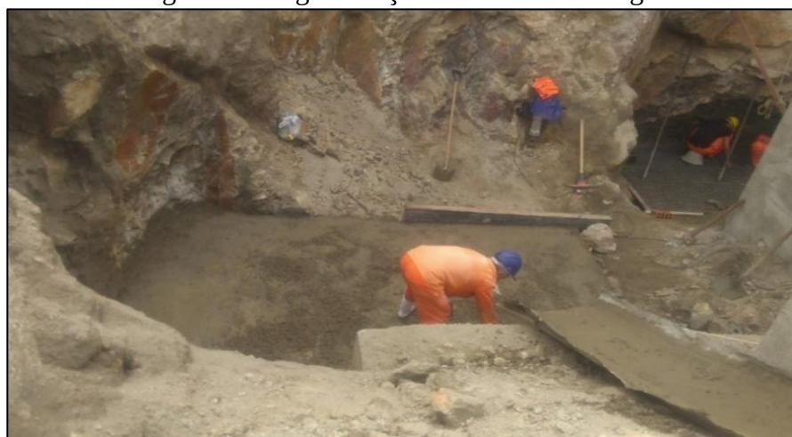
Figura 14: Regularização com concreto magro
