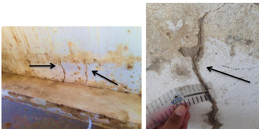
Figura 42 – Fissuras causadas por recalque da fundação
