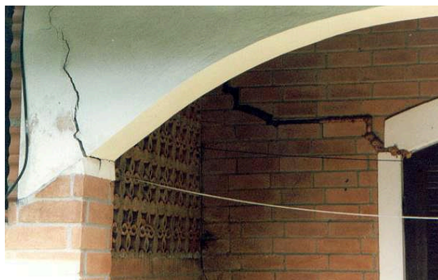
Figura 4 - Rachadura
