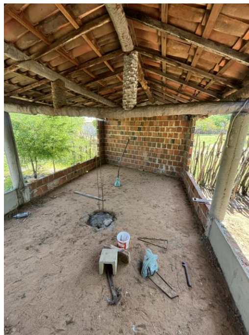
Figura 12 – Construção de galpão.
