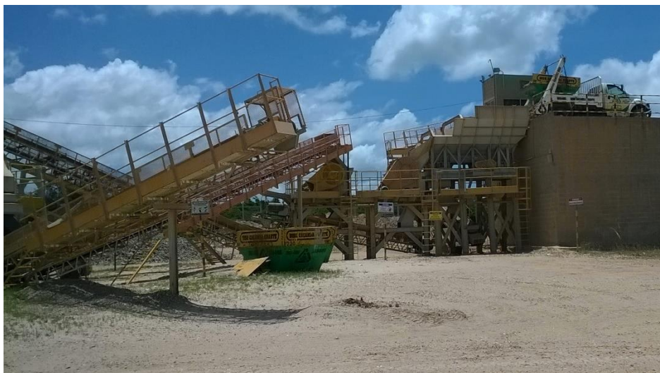
Figura 07 – Britagem (a) e estocagem (b)
