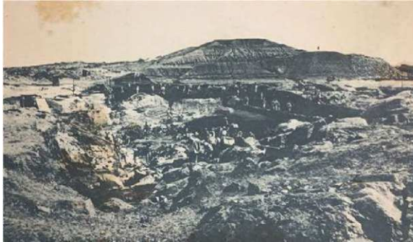
Figura 69 - Construção do Açude Itans
