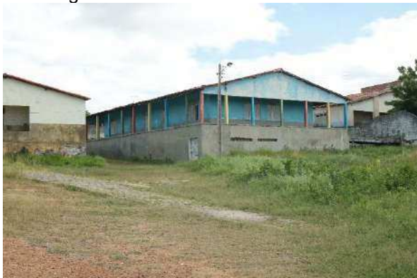
Figura 108 – Bloco de salas de aula II
