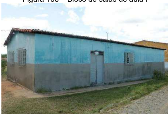
Figura 106 – Bloco de salas de aula I
