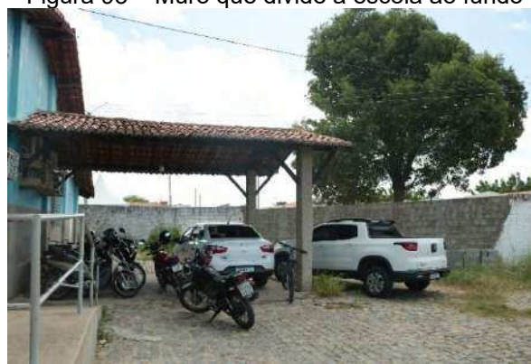
Figura 93 – Muro que divide a escola ao fundo
