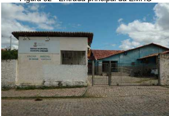
Figura 92 - Entrada principal da EMHG
