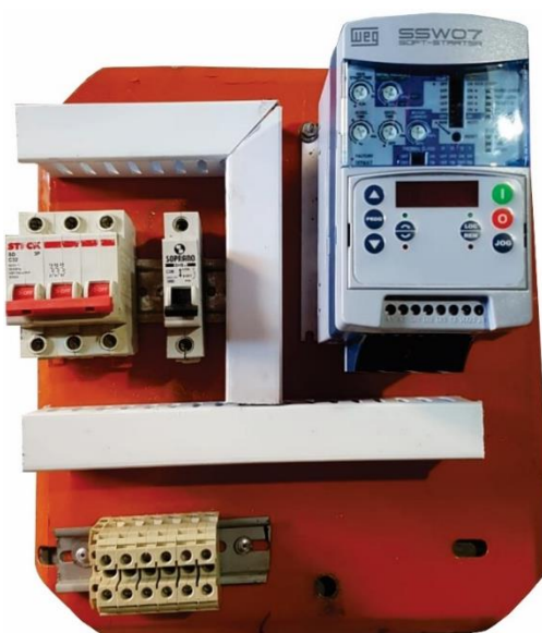
Figura 41 – Fixação dos componentes na placa do quadro de comando.
