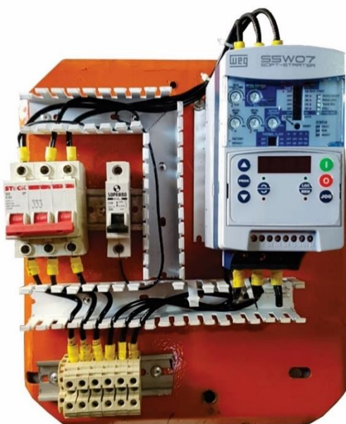
Figura 42 – Ligação do circuito de força.
