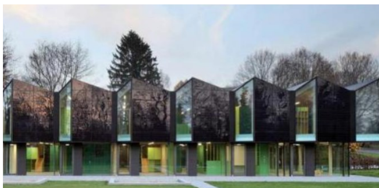
Figura 16: Fachada BIPV preta com vidro laminado em um edifício público.
