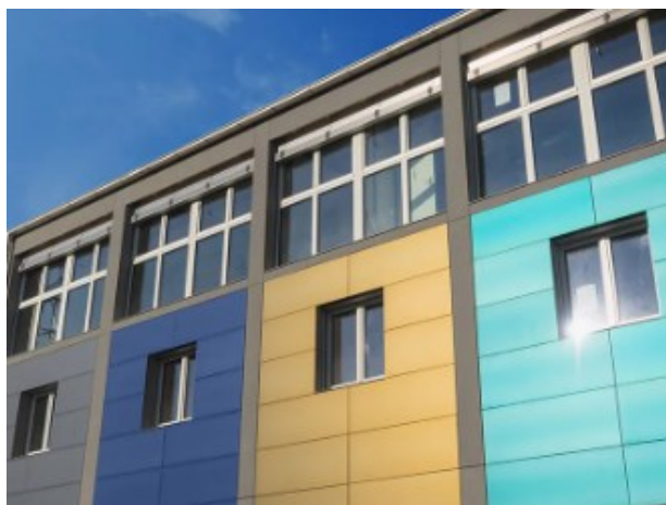
Figura 19: Fachadas duplas com persianas fotovoltaicas.
