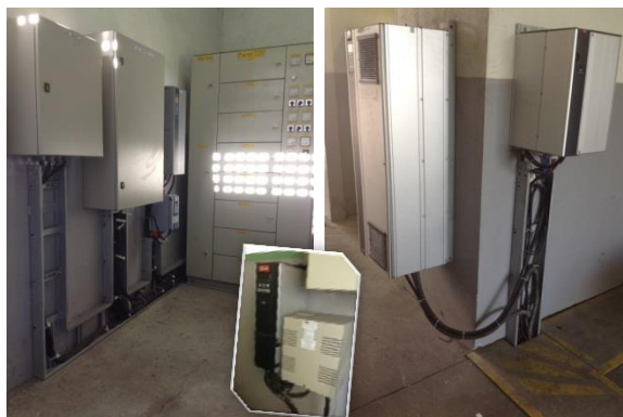
Figura 26 – Visão geral das instalações dos novos painéis e drivers do SAA.
