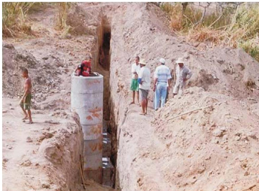
Figura 12 - Vala escavada e Implantação de Poço Amazonas
