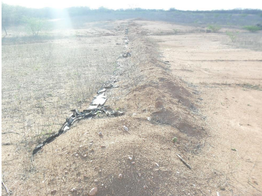
Figura 18 - Barragem construída na propriedade de Francisco Jose de Oliveira
