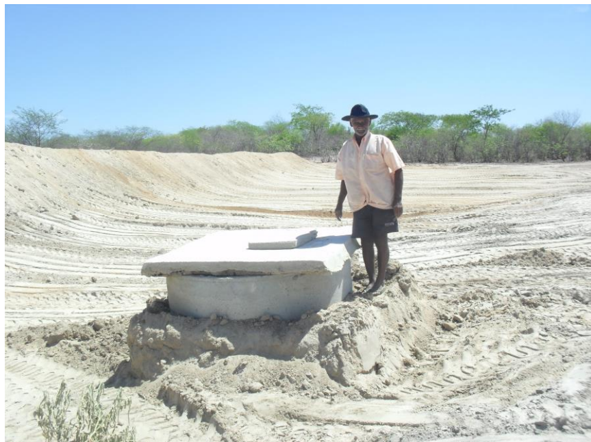
Figura 16 - Barragem construída na propriedade de Eutario Marcolino Braga
