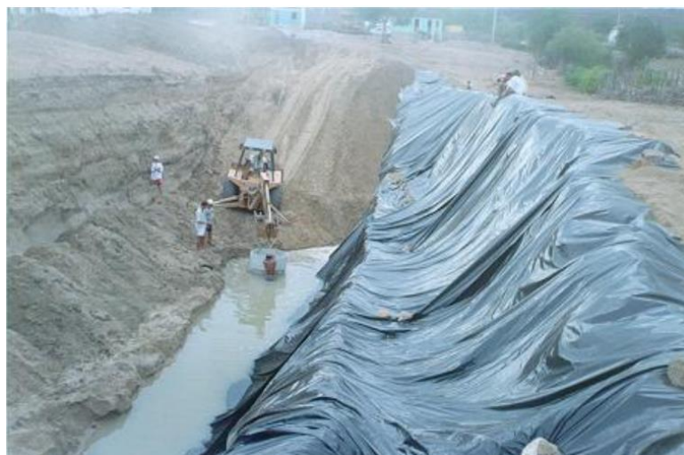
Figura 11 - Colocação da Lona Plástica e Implantação de Poço
