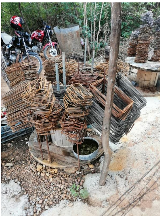
Figura 18: Ferragem para construção do poste
