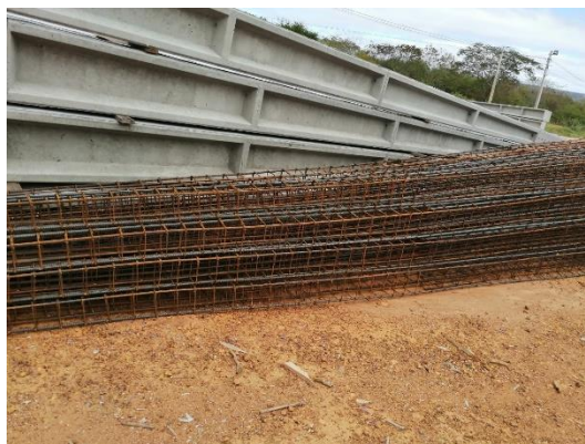
Figura 19: Ferragem para construção do poste
