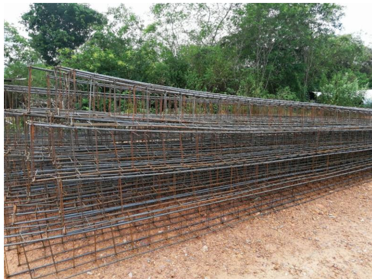
Figura 24: Armazenamento de ferragem
