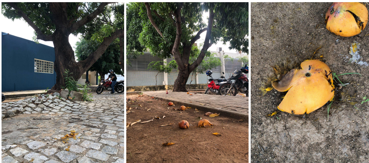
Figura 6. Danos ao pavimento e acúmulo de frutos em decomposição causados por mangueiras.
