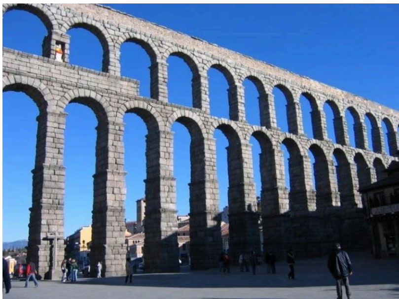
Figura 1 – Vão em alvenaria estrutural histórica
