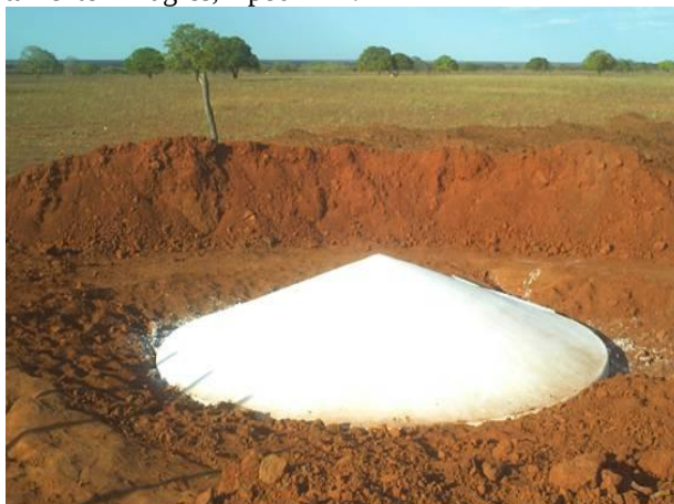
Figura 6. Ilustração do reservatório para armazenamento do excesso de esgoto doméstico tratado no sistema alagado construído no assentamento Milagres, Apodi-RN.
