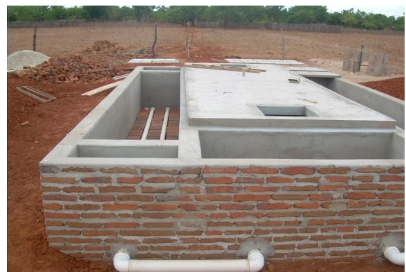
Figura 2. Vista superior durante a construção do decanto-digestor (a) e vista superior semi-pronta (b) no assentamento Milagres, Apodi-RN.
