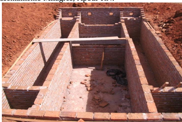
Figura 2. Vista superior durante a construção do decanto-digestor (a) e vista superior semi-pronta (b) no assentamento Milagres, Apodi-RN.
