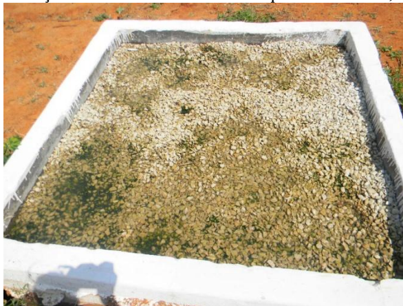
Figura 17. Ilustração do Filtro anaeróbio no Parque Zoobotânico, Mossoró-RN.
