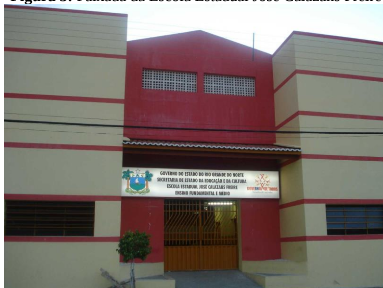
Figura 3: Faixada da Escola Estadual José Calazans Freire
