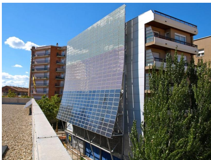
Figura 13 - Exemplo de BIPV.
