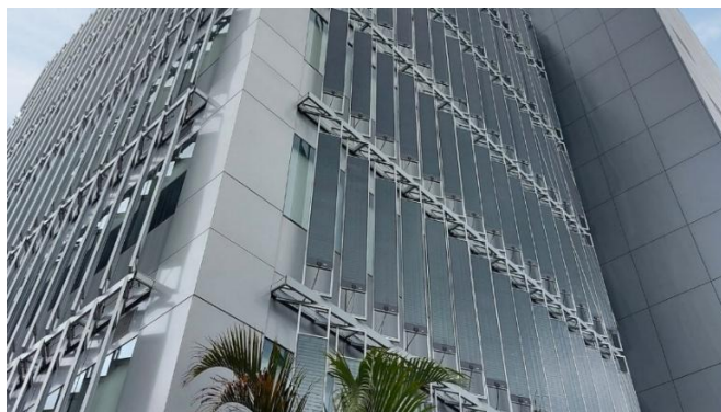
Figura 29 - Módulos fotovoltaicos do edifício.
