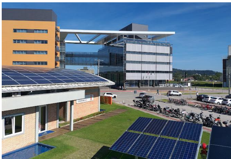
Figura 21 - Laboratório de Energia Solar Fotovoltaica da UFSC em Florianópolis.
