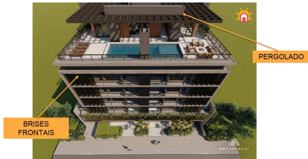
Figura 31 - Brises fotovoltaicos verticais e pergolado semitransparente.
