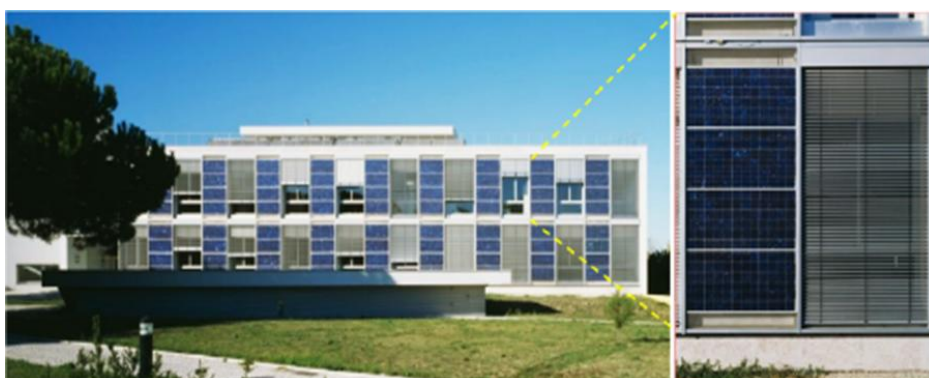
Figura 12 - Fachada composta por sistemas BIPV.
