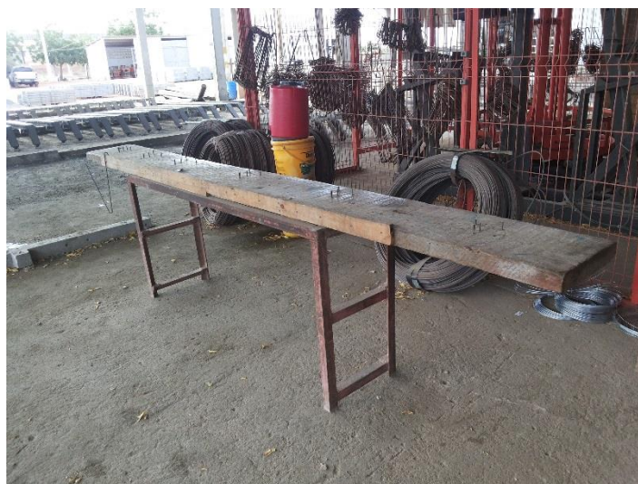
Figura 4. Mesa com gabarito para confecção manual de estribos. Fonte: Autoria própria
