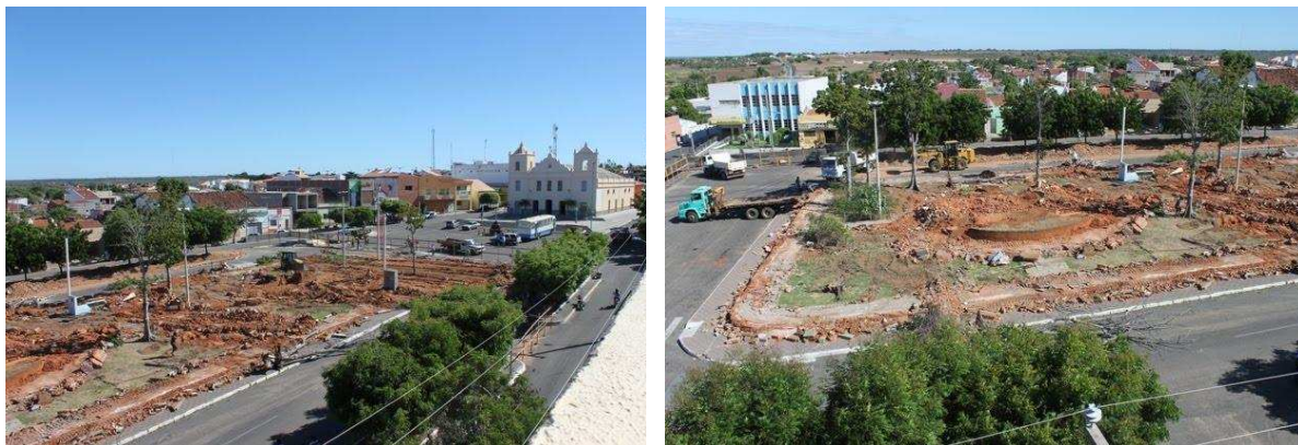
Figura 30 – Processo de reforma da Praça Dom José Freire, Apodi, Rio Grande do Norte.
