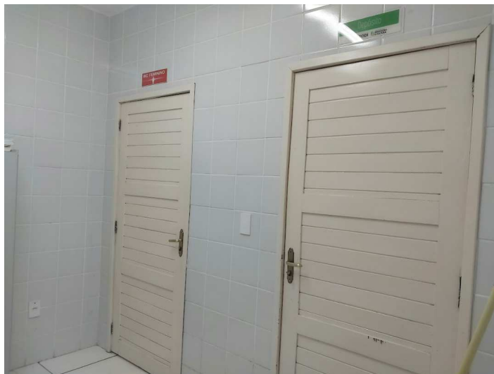
Figura 46 – Acesso aos banheiros da Biblioteca Valter Brito Guerra – Apodi/RN.
