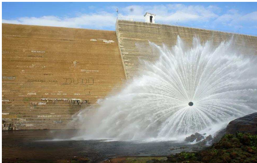
Figura 23 - Barragem de Santa Cruz, Rio Grande do Norte.
