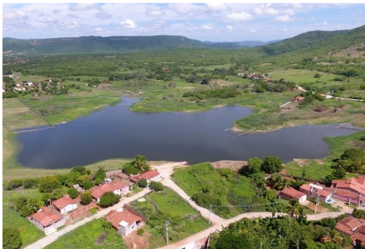
Figura 8 - Vista aérea da barragem Municipal.
