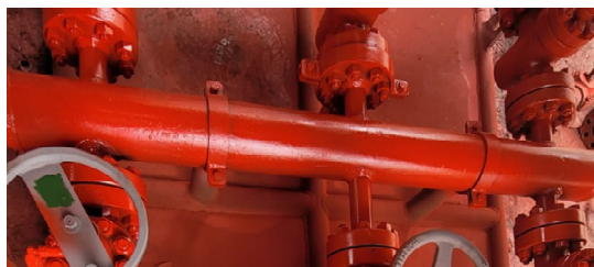
Figura 8- Vaso de pressão 3000 PSI com seis conexões de válvulas (Autoria Própria).
