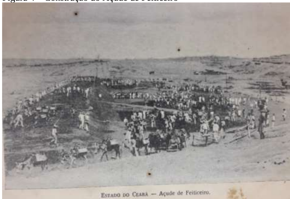
Figura 4 – Construção do Açude de Feiticeiro
