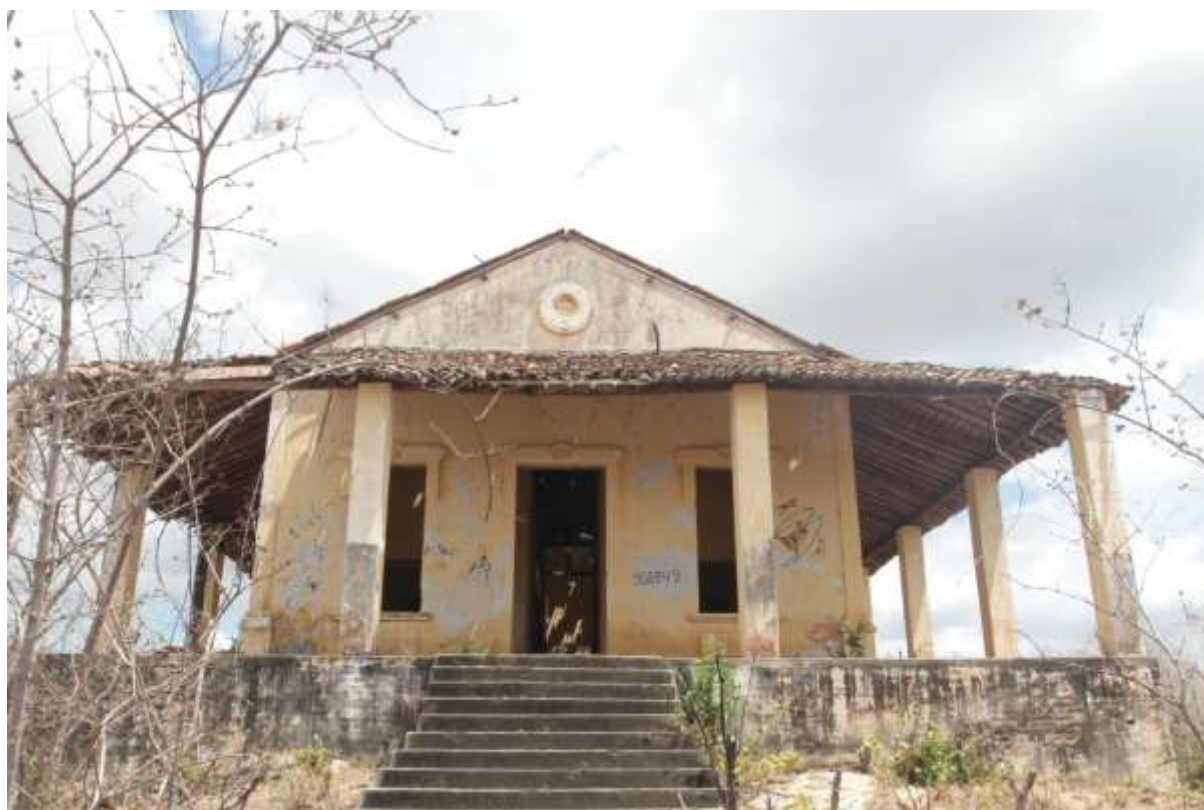
Figura 13 – Casarão onde funcionou a estrutura administrativa do Campo de Concentração do Patu
