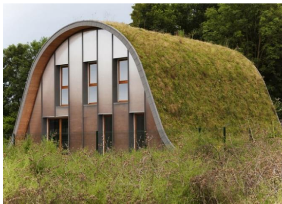
Figura 8 – Telhado verde do edifício La Maison-vague
