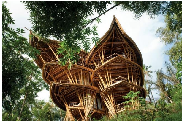
Figura 10 – Obra inteiramente construída com o material bambu
