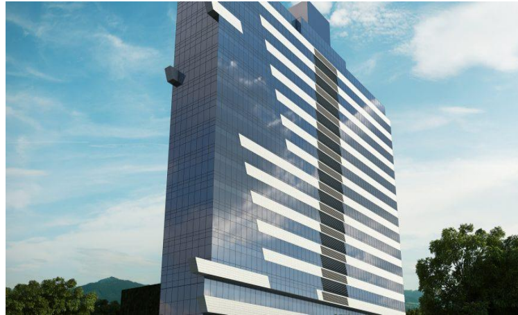
Figura 19 – Edifício Eurobusiness primeiro a ganhar Certificado LEED Zero Water
