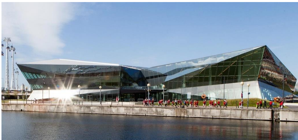
Figura 17 – Edifício The Crystal aberto para visitas
