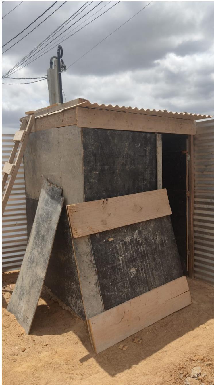
Figura 08: Visão externa do banheiro e vestiário da obra estudada
