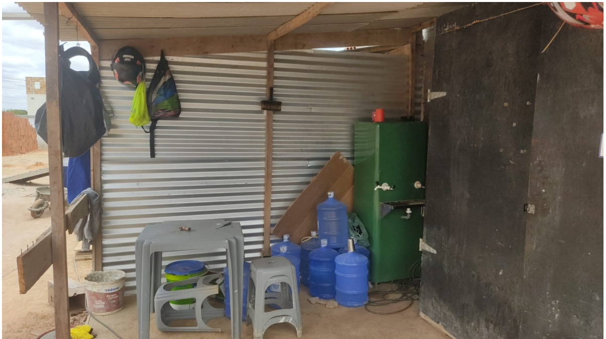
Figura 11: Almoxarifado e refeitório da obra estudada
