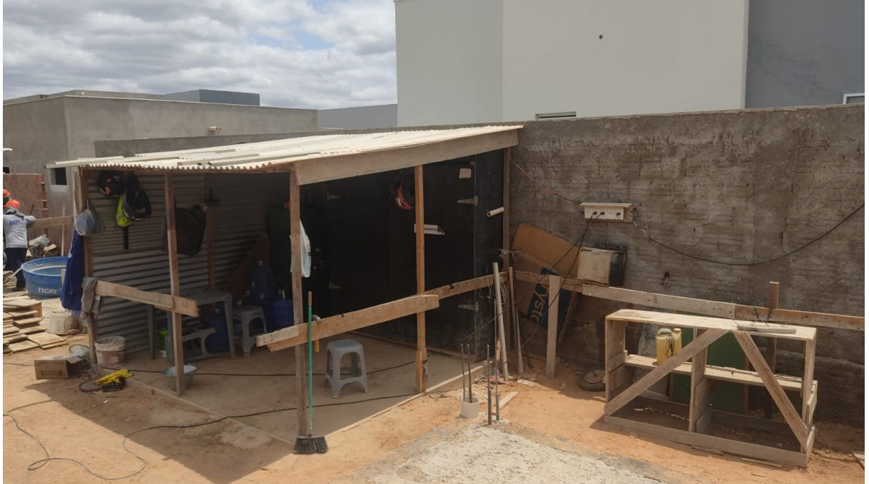
Figura 10: Almoxarifado e refeitório da obra estudada
