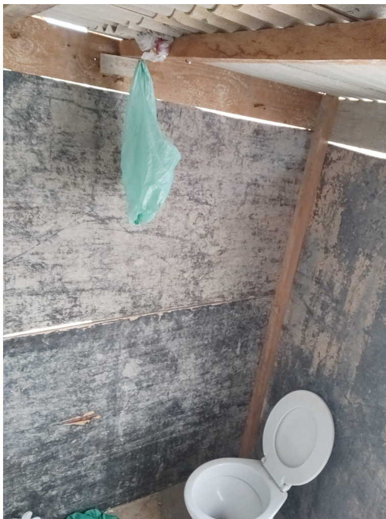
Figura 09: Visão interna do banheiro e vestiário da obra estudada
