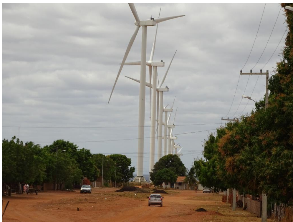
Foto 07 – Proximidade de Residências dos Aerogeradores na vila Guanabara
