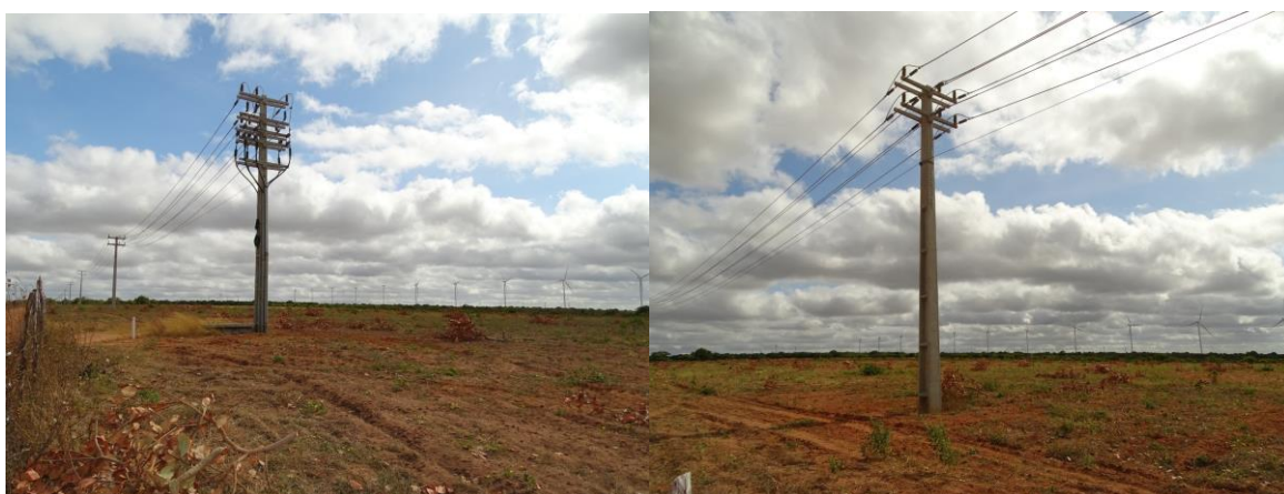
Foto 05 – Cabos da Linha de Transmissão Instalados na vila Guanabara.
