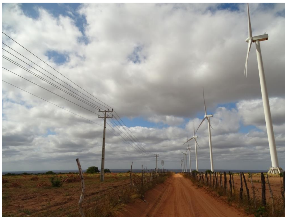
Foto 11 – Estrada de Acesso ao Parque Eólico
