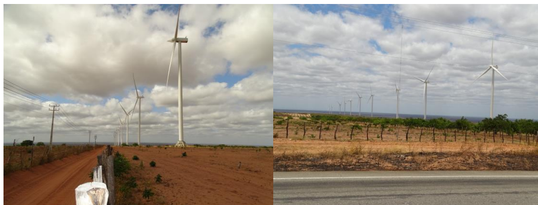
Foto 06- Área de Uso de Aerogeradores 6
