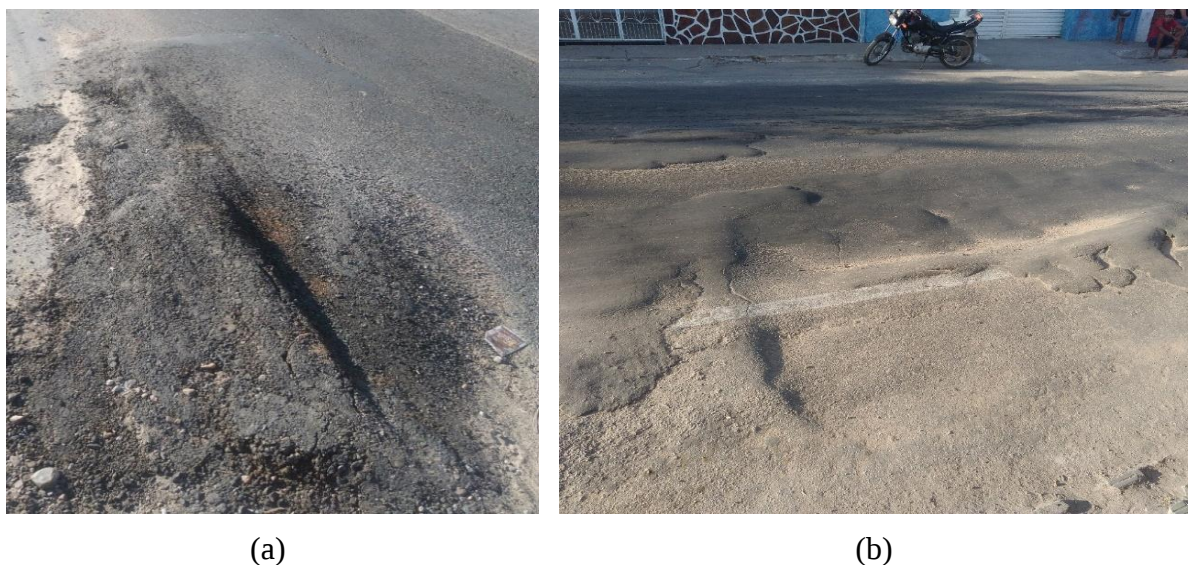
Figura 04: Afundamento
