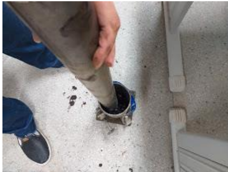
Figura 38: Adensamento das camadas de asfalto
