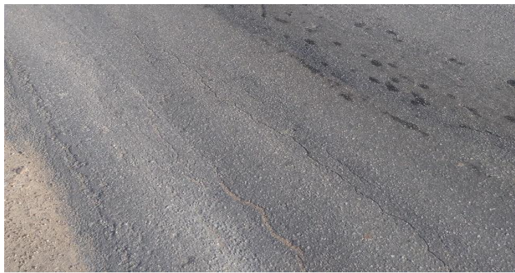
Figura 09: Fissuras
