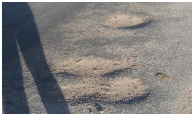
Figura 06: Formação de panelas
