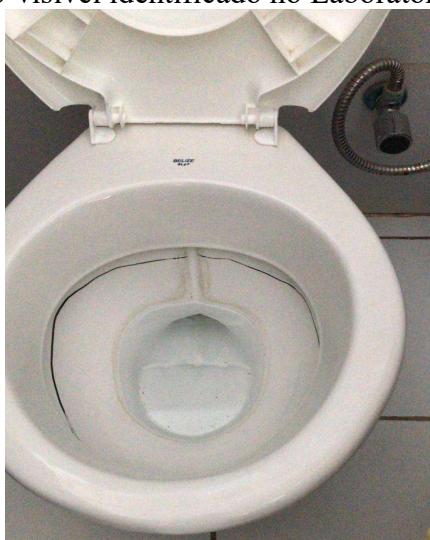
Figura 41: Vazamento não-visível identificado no Laboratório de Engenharia II
