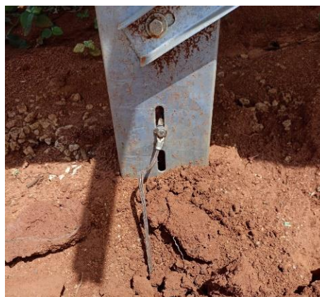
Fig. 12. Aterramento das estacas de fixação das mesas dos módulos.
