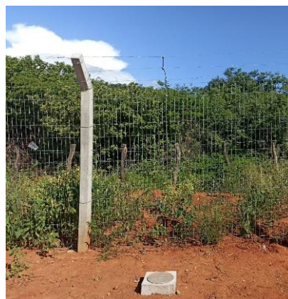
Fig. 14. Aterramento da cerca da UFV.
