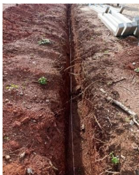
Fig. 6. Lançamento dos cabos de cobre nú 50mm 2 na malha geral.
