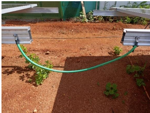
Fig. 16. Aterramento entre mesas sequenciais
