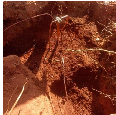
Fig. 19. Instalação dos grampos GTDU.
