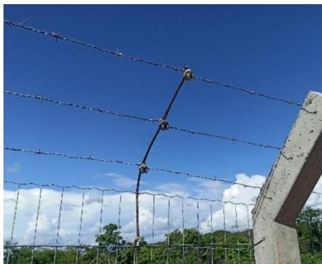
Fig. 21. Aterramento na cerca e arames farpados utilizando splitbolt.
