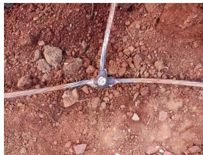
Fig. 23. Solda exotérmica tipo T.
