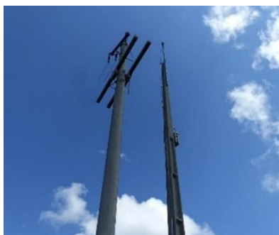
Fig. 9. Instalação do captor tipo Franklin.
