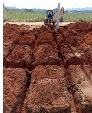
Fig. 8. Escavação da malha da cabine de medição e proteção.
