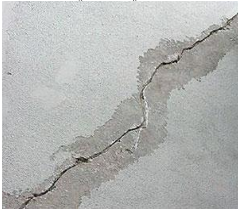
Figura 6 - Fissura geométrica.
