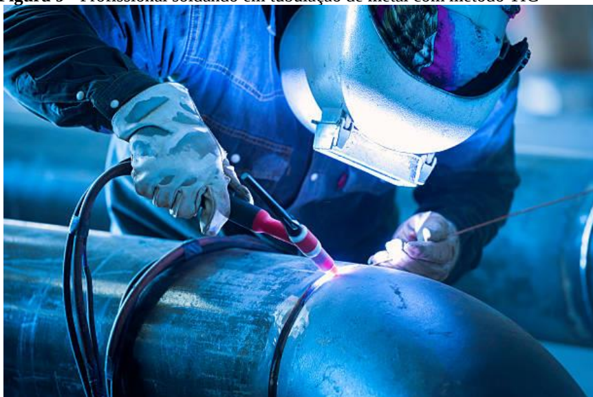
Figura 9 - Profissional soldando em tubulação de metal com método TIG
