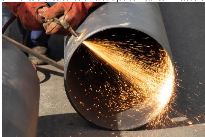
Figura 19 - Profissional soldando em tubulação de metal com método Oxigás
