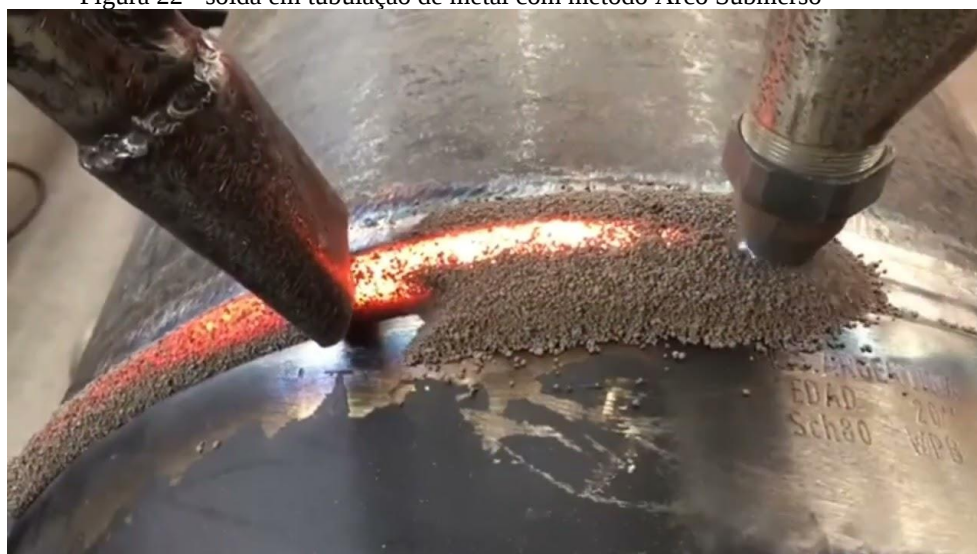
Figura 22 - solda em tubulação de metal com método Arco Submerso
