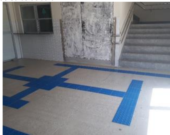
b) Escadas sinalizada e com corrimãos.
