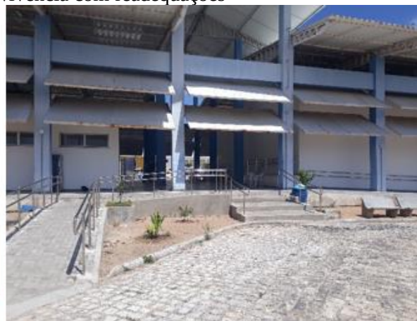
b) Rampa e guarda-corpos.
