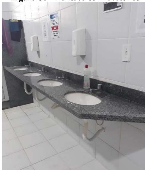
Figura 30 – Bancada com lavatórios
