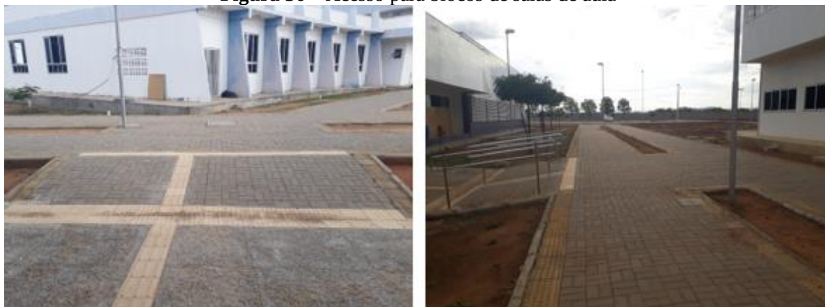
Figura 36 – Acesso para blocos de salas de aula
