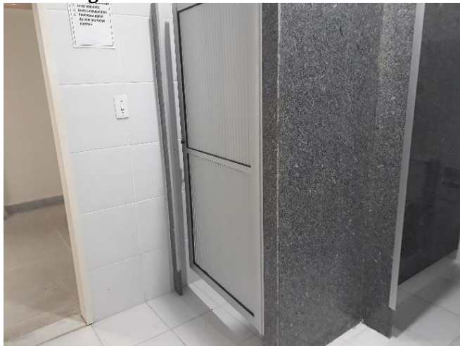
Figura 42 – Porta de sanitário acessível
