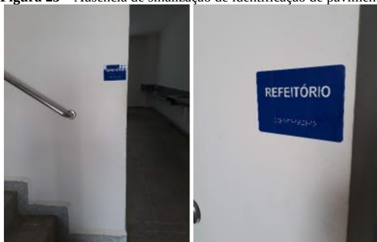
Figura 25 – Ausência de sinalização de identificação de pavimento
