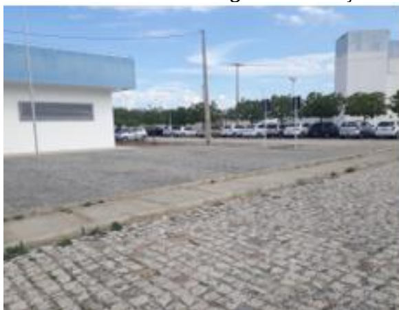
a) Acesso da biblioteca para o estacionamento.
