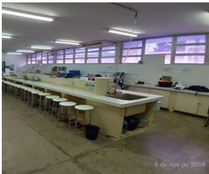
Figura 5 – Janelas de ferro com vidro.
