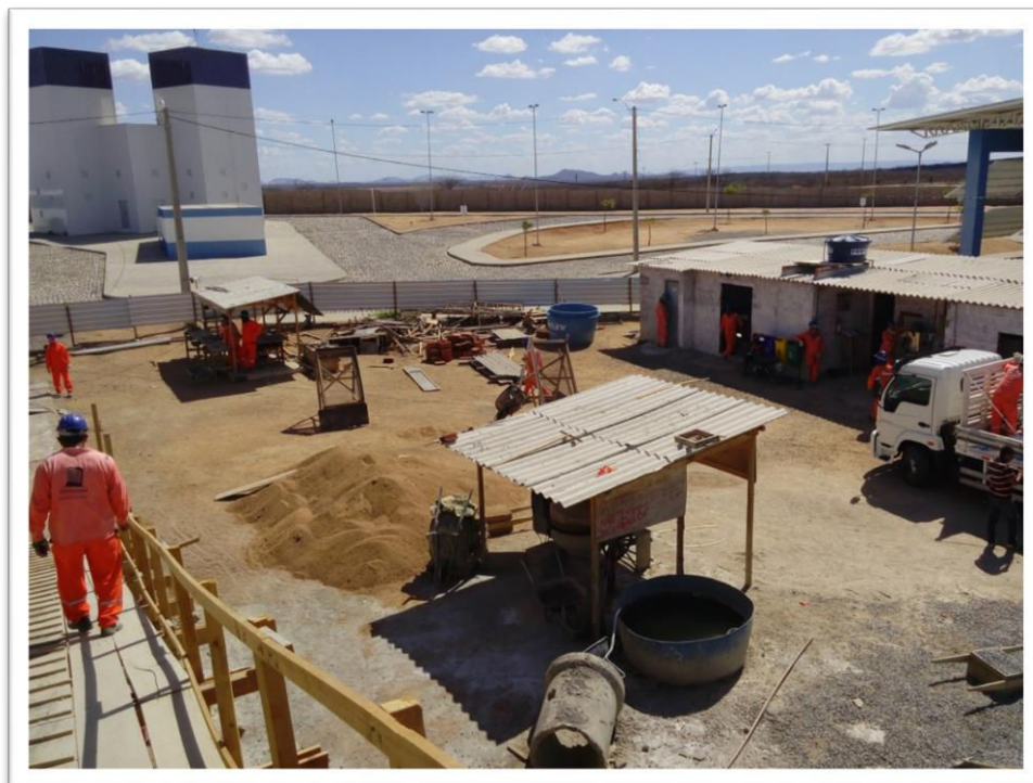
Figura 1 – Canteiro de obra
