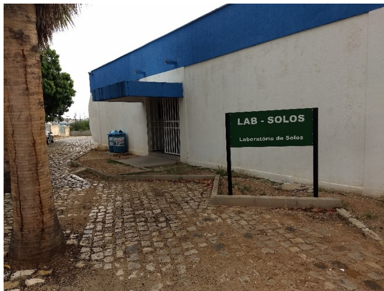
Figura 52 - Fachada do prédio do Laboratório de Solos (Ponto 2).
