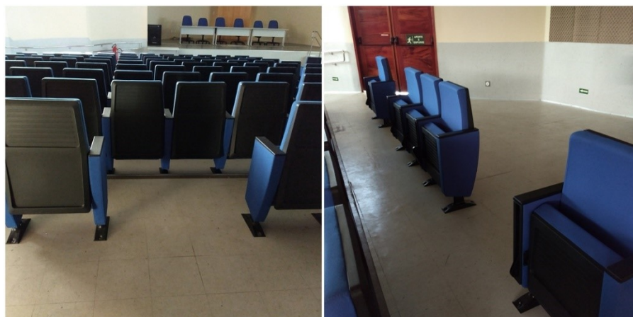
Figura 46 - Áreas destinadas a cadeirantes sem demarcações.
