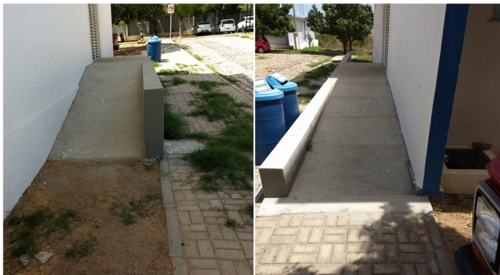
Figura 56 - Rampa de acesso para o prédio do Laboratório de Tecnologia de Alimentos (Ponto 8).
