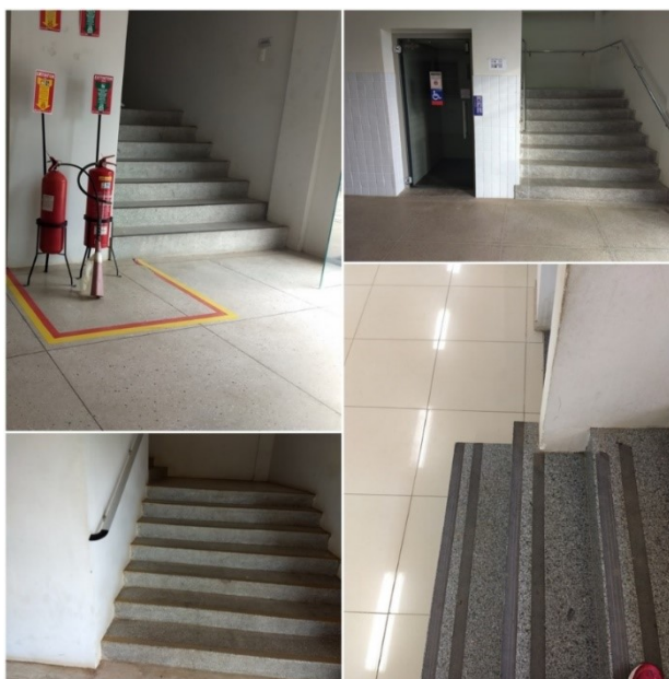
Figura 40 - Detalhe das escadas com relação aos itens não atendidos.
