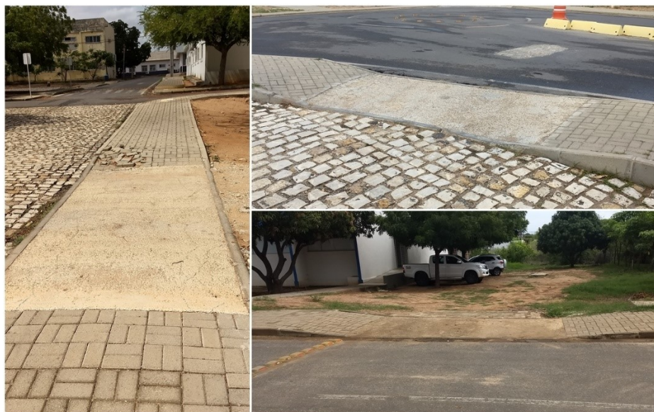
Figura 50 - Acesso de veículos para o interior do lote.
