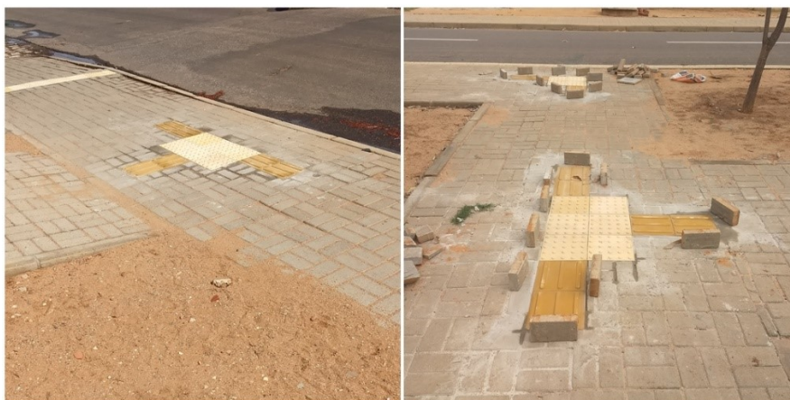
Figura 37 - Instalação de piso tátil em mudança de direção.
