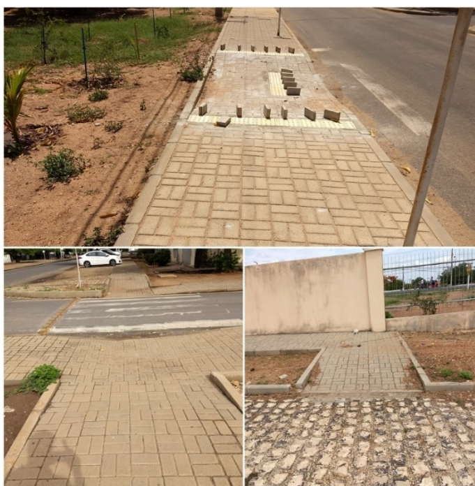
Figura 38 - Instalação de piso tátil de alerta e guias rebaixadas sem piso tátil de alerta.
