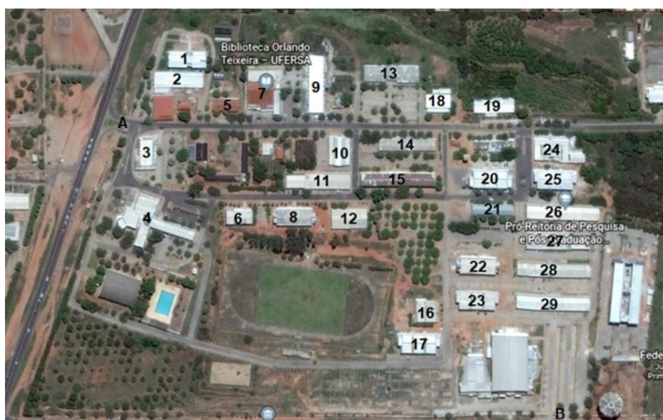
Figura 31 - Prédios do campus lestes da UFERSA - Mossoró.
