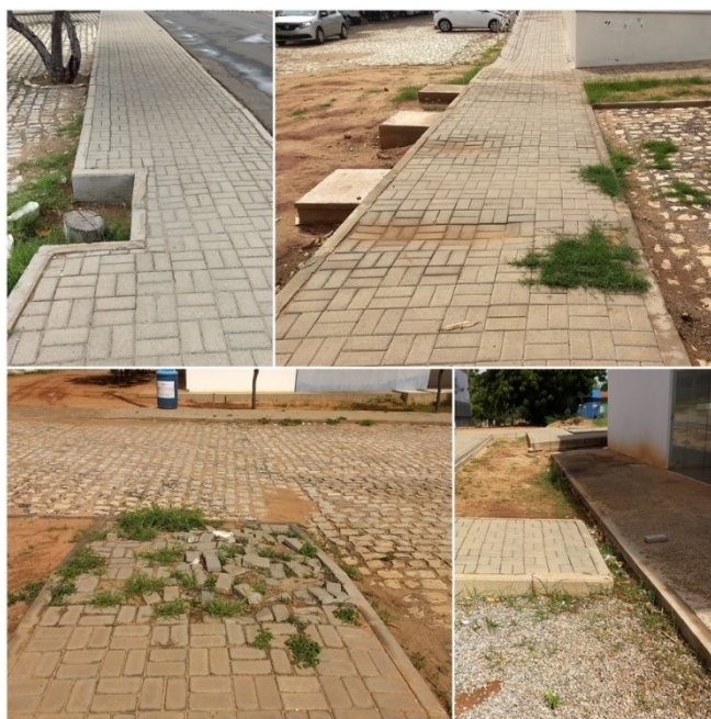
Figura 36 - Buracos e rebaixamentos dos pisos em calçadas.
