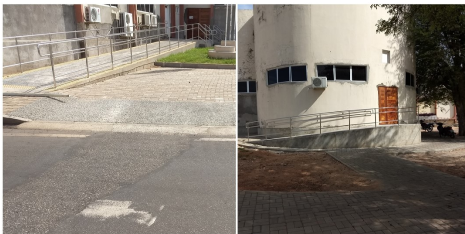
Figura 45 - Rampas para acesso ao auditório.
