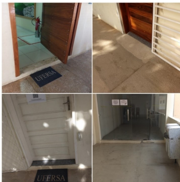
Figura 39 - Entrada dos ambientes do prédio da reitoria.
