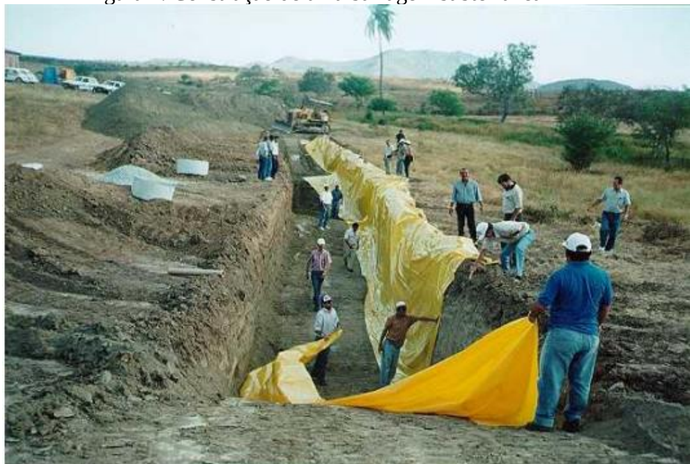
Figura 2: Construção de uma barragem subterrânea
