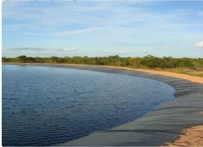
Figura 4: Aplicação de geomembrana – proteção ambiental
