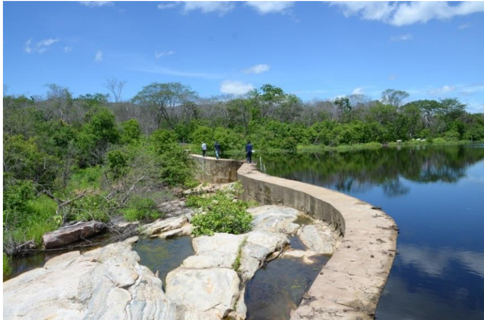
Figura 12: Barragem da Fazenda Serra da Madalena.
