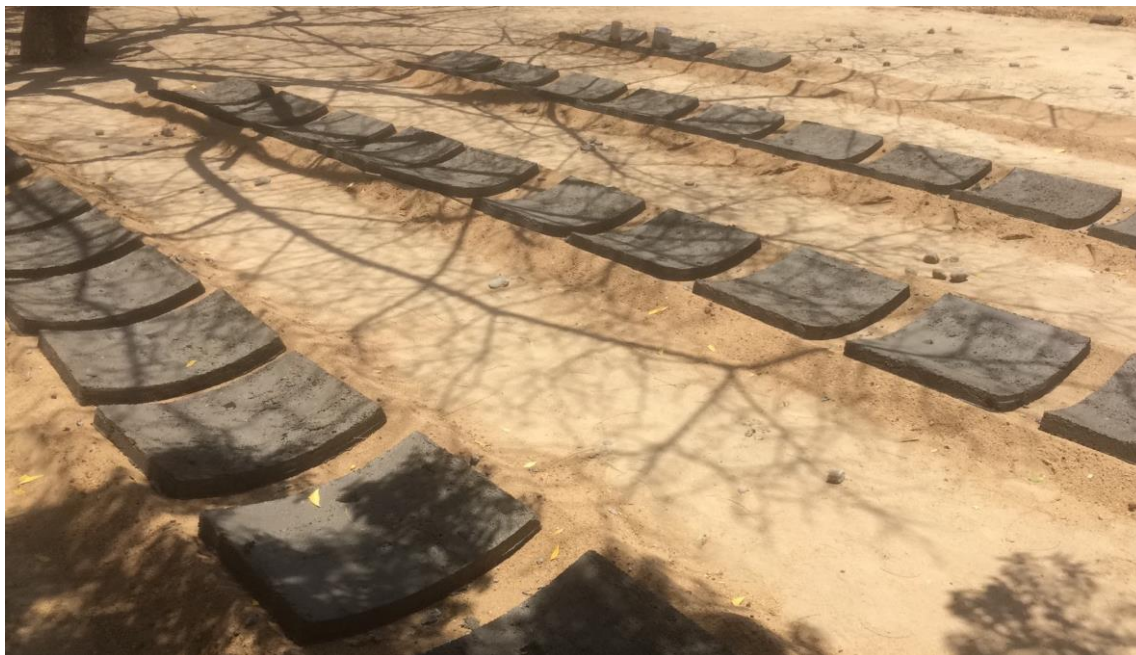
Figura 13: Placas prontas para produção do tanque digestor
