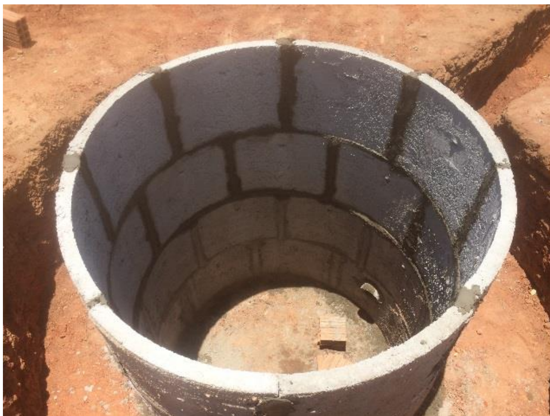
Figura 15: Parede do tanque digestor totalmente levantada
