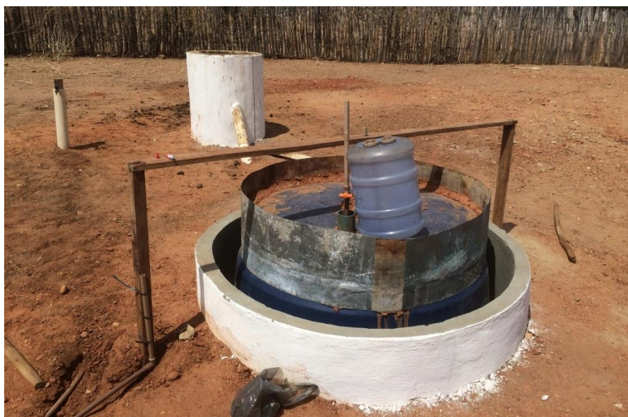
Figura 20: Gasômetro instalado no tanque digestor
