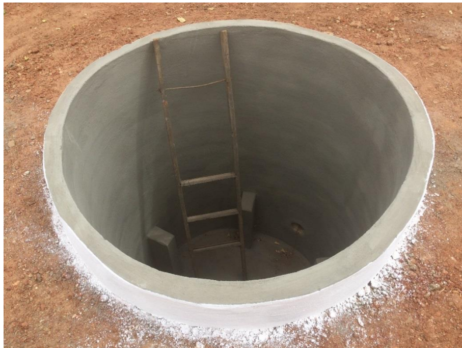
Figura 16: Tanque digestor rebocado
