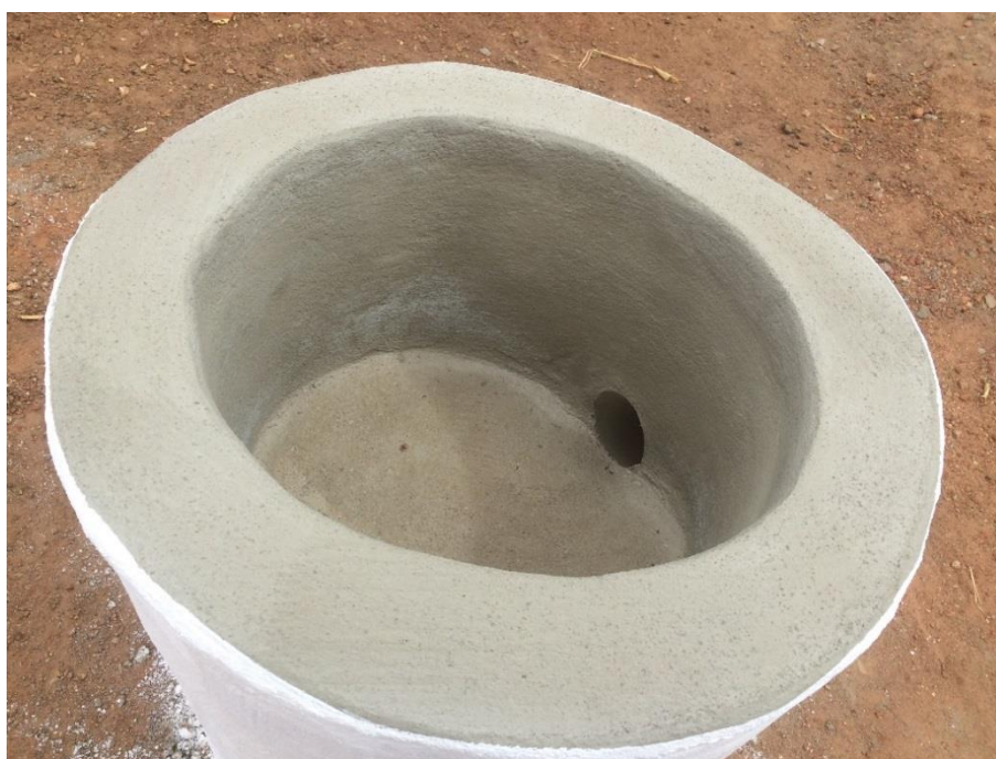
Figura 17: Tanque de mistura rebocado
