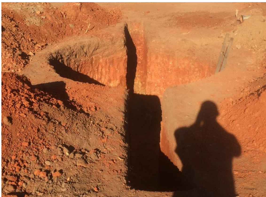
Figura 11: Valas do encanamento
