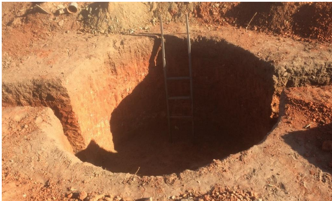
Figura 12: Escavação do tanque digestor
